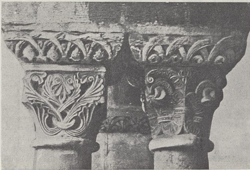
Abb. 33. Kapitelle von der Pfalz Barbarossas in Gelnhausen.
