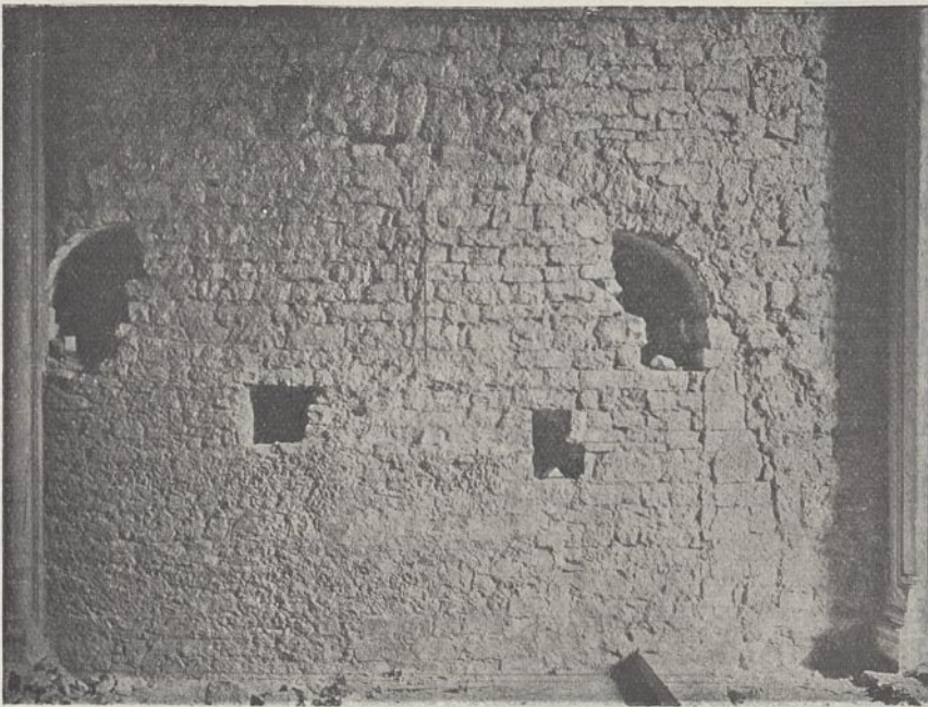
Abb. 7. Nördliche Chorwand nach der Freilegung.
