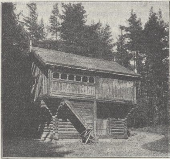
Abb. 48. Schlafhaus aus Rolstad in Gulbrandsdalen. (Nach Mühlke, Denkmalpflege 1900, S. 17.)
