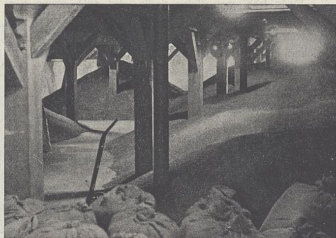
Abb. 14. Lagerboden mit (durch Denny-Stützen) verteiltem Korn.
