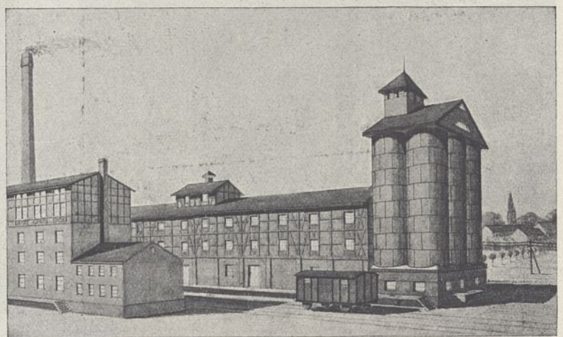
Abb. 18. Dampf- und Wassermühlenwerk Isenschnibbe bei Gardelegen. (Ammе, Giesecke u. Konegen A.-G., Braunschweig).
