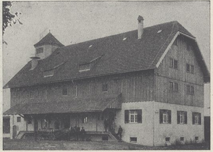
Abb. 16. Lagerhaus Neumarkt der Bayerischen Zentral-Darlehnskasse in München (H. Greffenius, Frankfurt a. M.).
