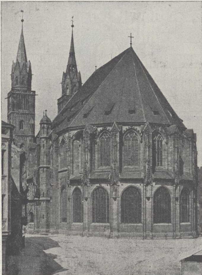
Abb. 22. St. Lorenzkirche. Ostseite. Vor 190 0.
