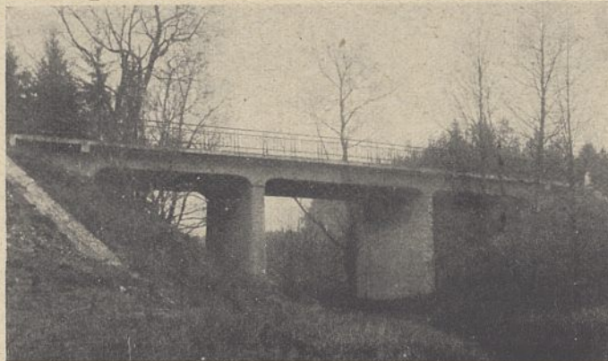
Abb. 12. Stonskifließbrücke bei der Oberförsterei Taubenfließ (Kr. Tuchel). Eisenbeton-Plattenbalkenbrücke
