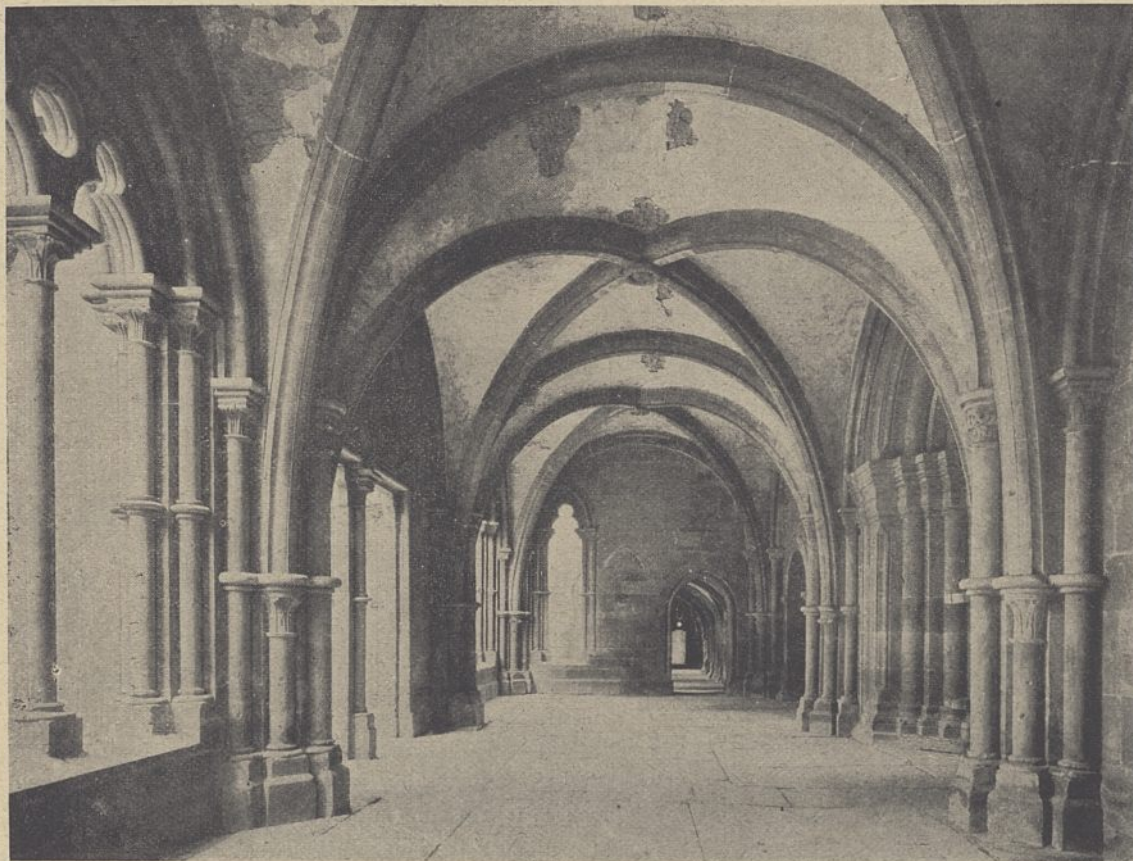
Abb. 6. Kloster Maulbronn. Vorhalle, Innenansicht.
