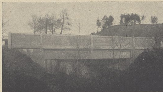
Abb. 27. Prondzonnafließbrücke bei Uplika (Kr. Schlochau). Plattenbalkenbrücke.
