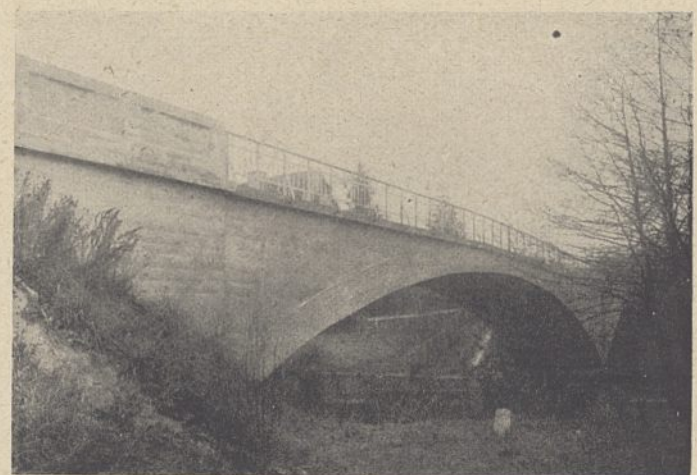
Abb. 4. Brahebrücke bei Pillamühl. Dreigelenkbogenbrücke aus Stampfbeton.
