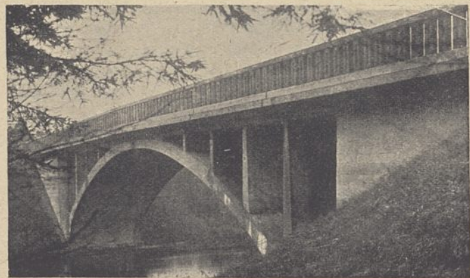
Abb. 33. Schwarzwasserbrücke oberhalb Altfließ (Kr. Schwetz). Eisenbeton-Dreigelenkbogenbrücke.
