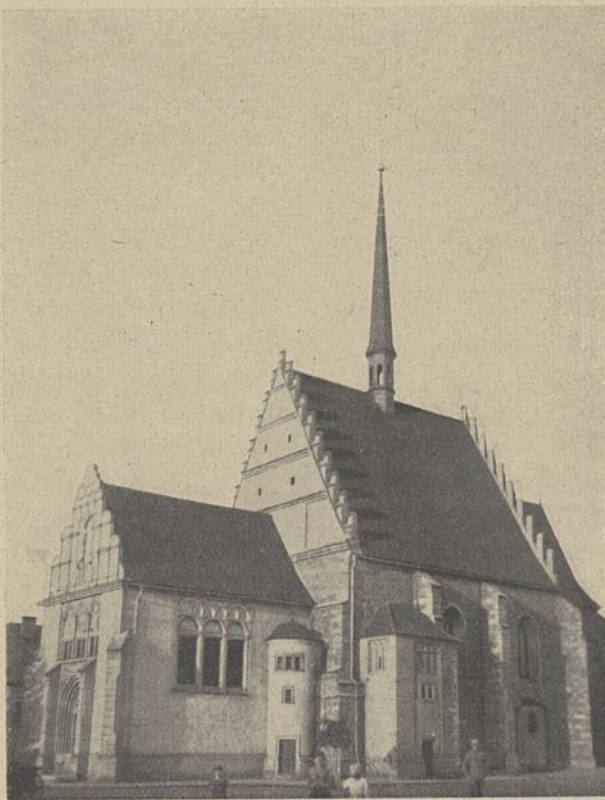
Abb. 11. St. Bartholomäuskirche. Südseite. Nach der Instandsetzung.
