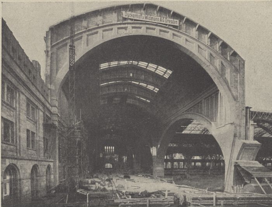
Abb. 166. Ansicht des Soffittenbinders III.
