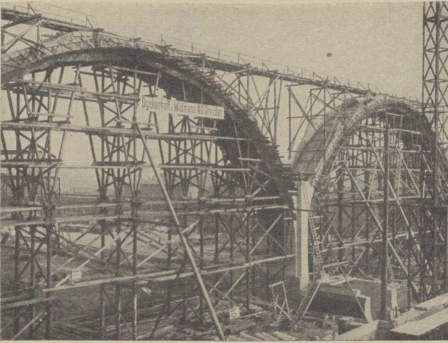
Abb. 188. Gerüst des Abschlußbogenbinders.
