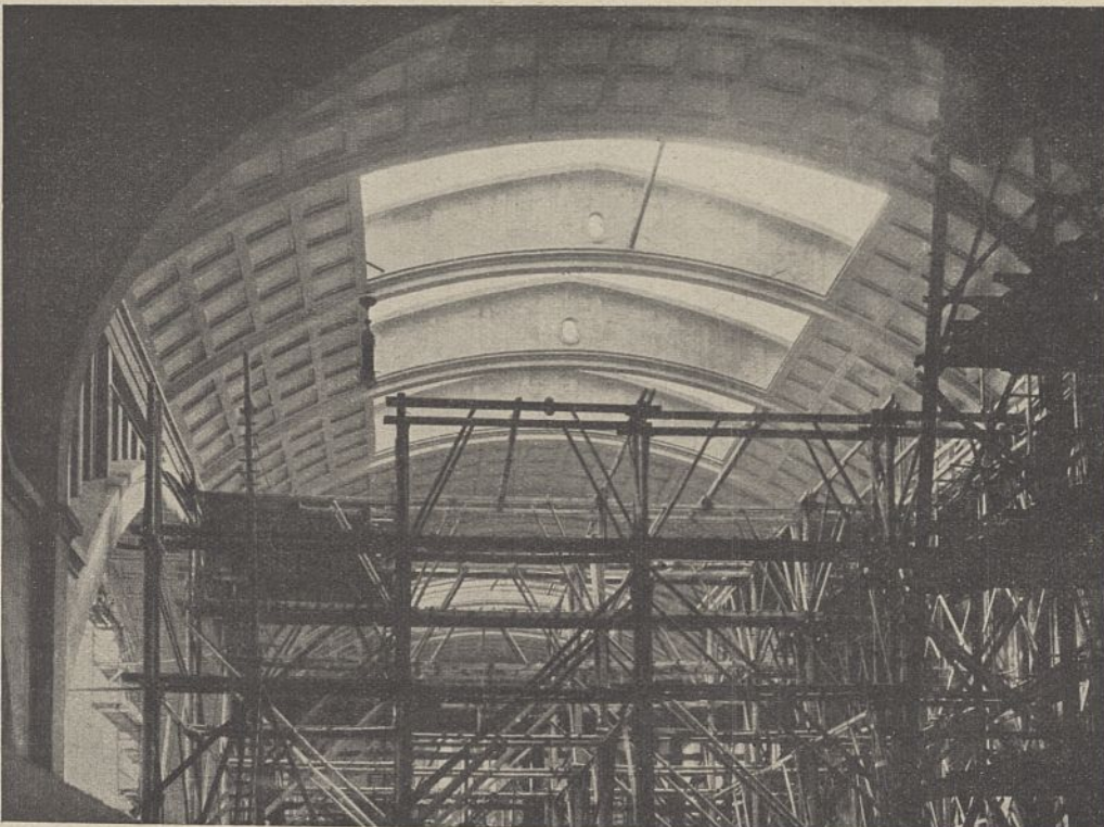
Abb. 193. Hallenuntersicht, Abbruch der Lehrgerüste.
