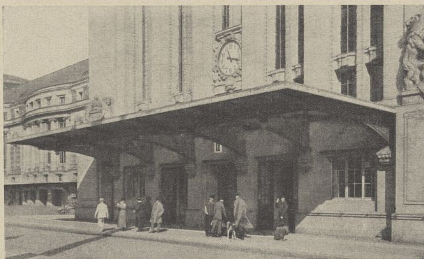
Abb. 114. Vordach vor der östlichen Eingangshalle.
