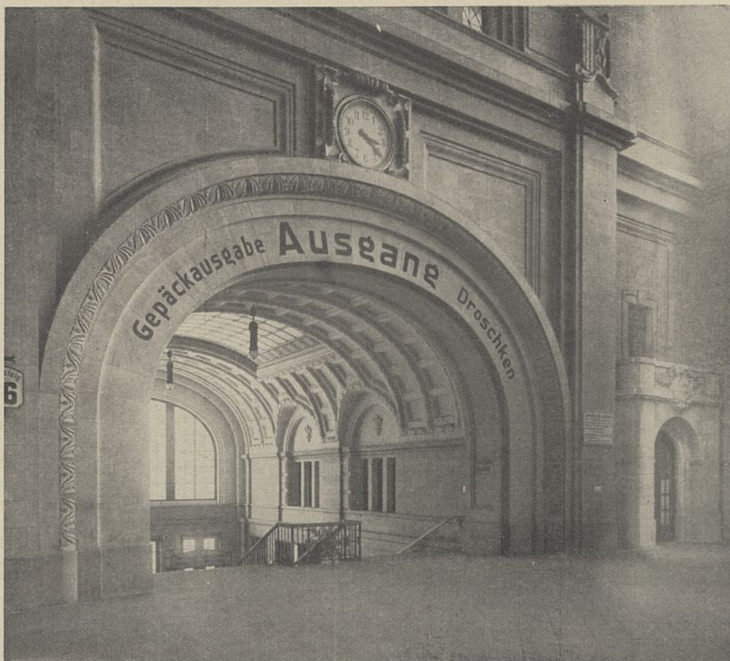
Abb. 120. Blick in die östliche Ausgangshalle.
