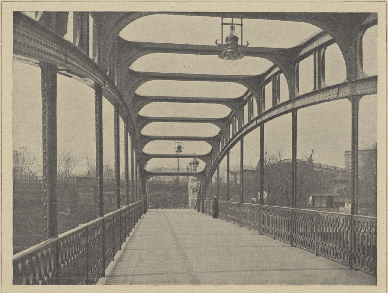
Abb. 13. Gerickesteg, Blick von der Gangbahn.
