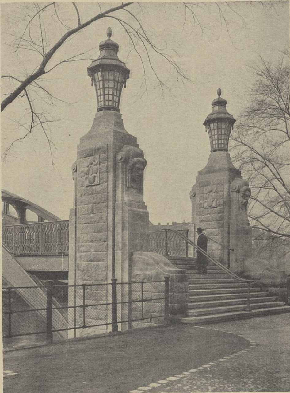
Abb. 14. Gerickesteg, nördlicher Zugang.
