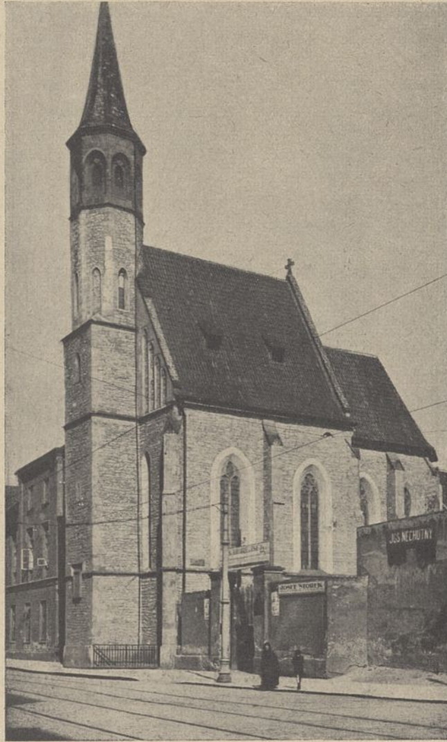
Abb. 2. Prag, Maria Verkündigungskirche in Kiep. Ansicht nach der Instandsetzung.
