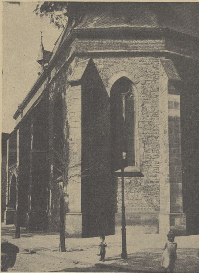
Abb. 5. Prag, St. Peterskirche am Porič. Choransicht. Nach der Instandsetzung.
