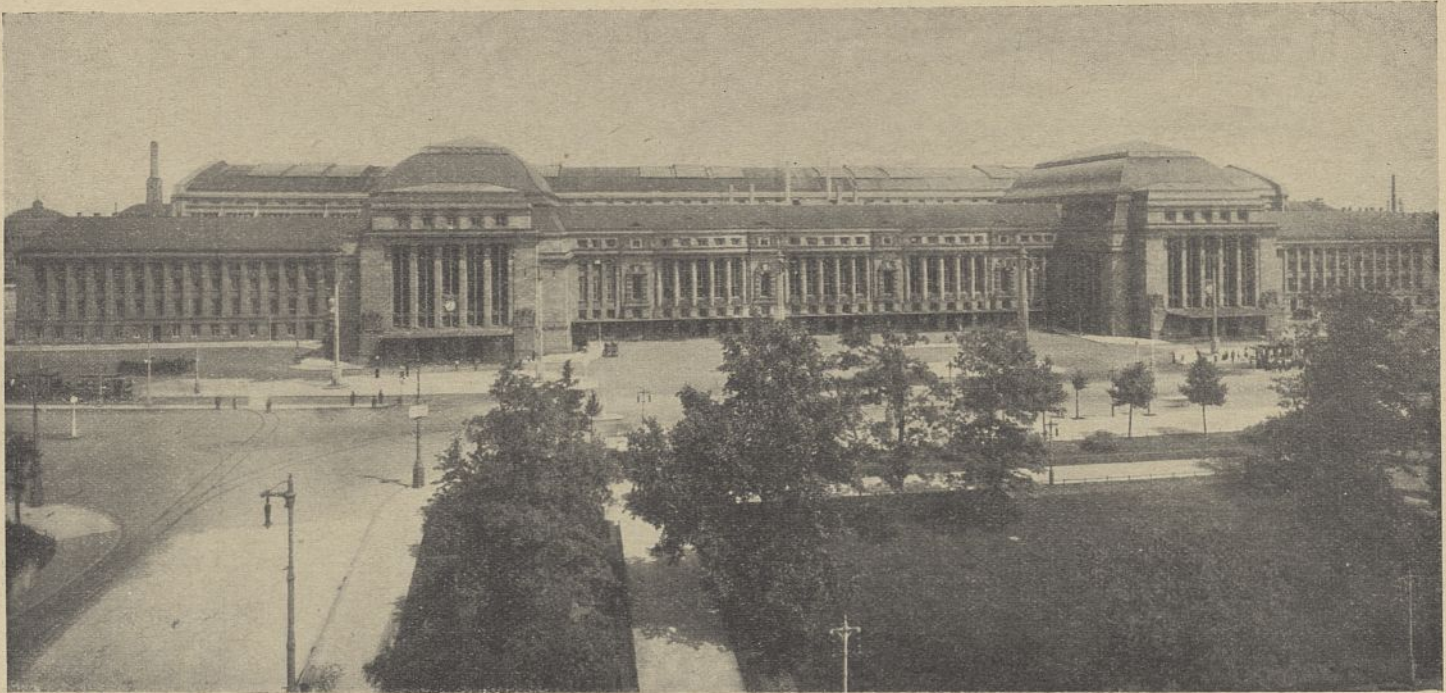
Abb. 109. Ansicht vom Vorplatz.
