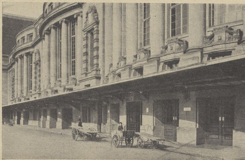
Abb. 117. Vordach vor dem Mittelbau.
