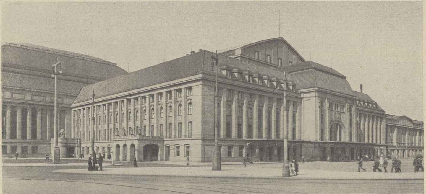
Abb. 111. Ansicht der östlichen Ausgangshalle.
