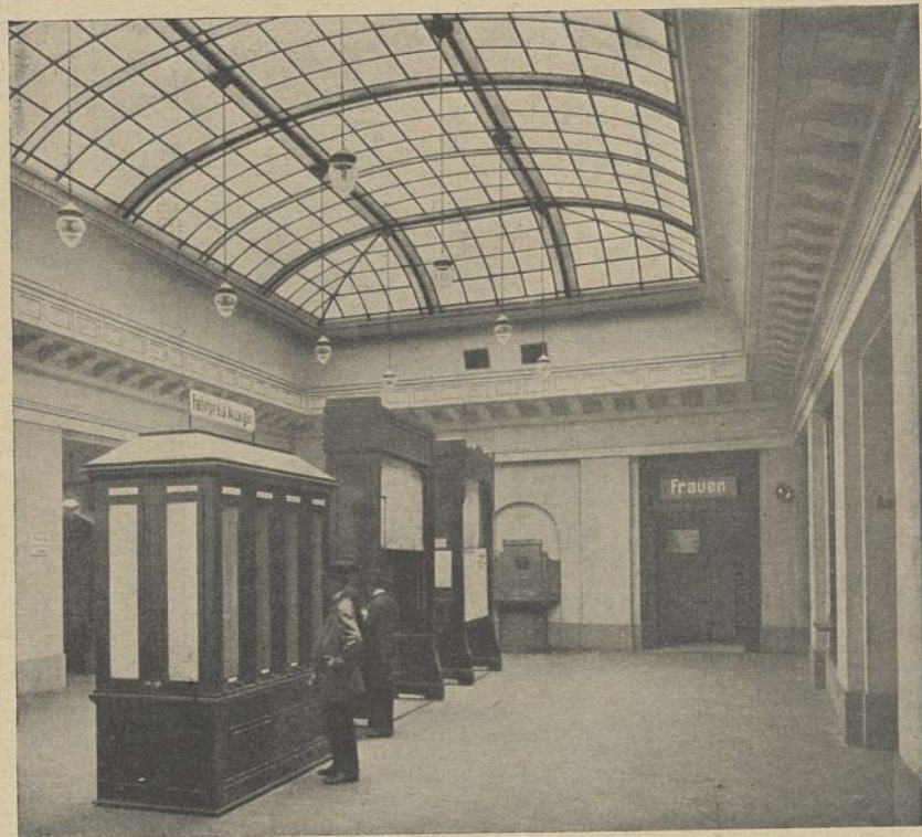
Abb. 122. Blick in die östliche Fahrplanhalle.
