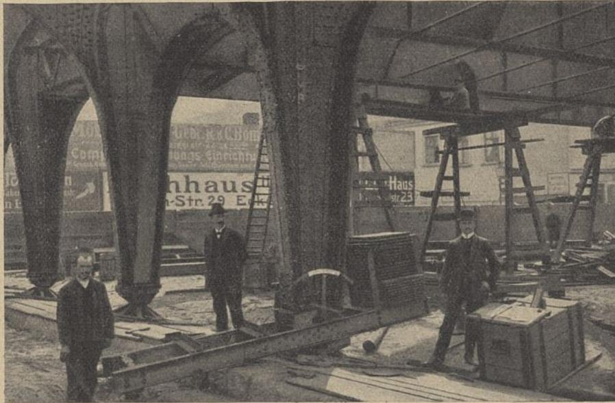
Abb. 79. Putlitzbrücke, Stellvorrichtung an IX<sub>D</sub> in Tätigkeit.
