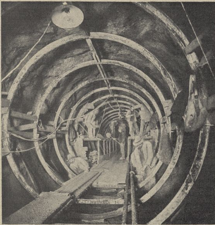
Abb. 18. Auskleidung des Stollens.
