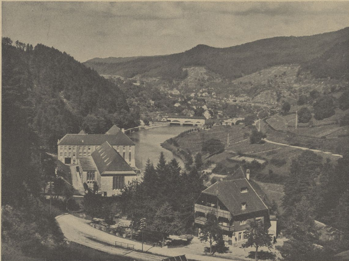
Abb. 25. Murgwerk und Forbach.
