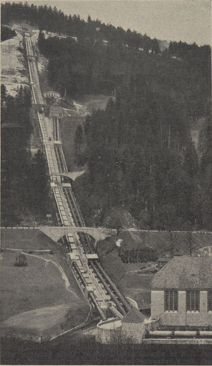
Abb. 21. Rohrbahn mit Krafthaus.
