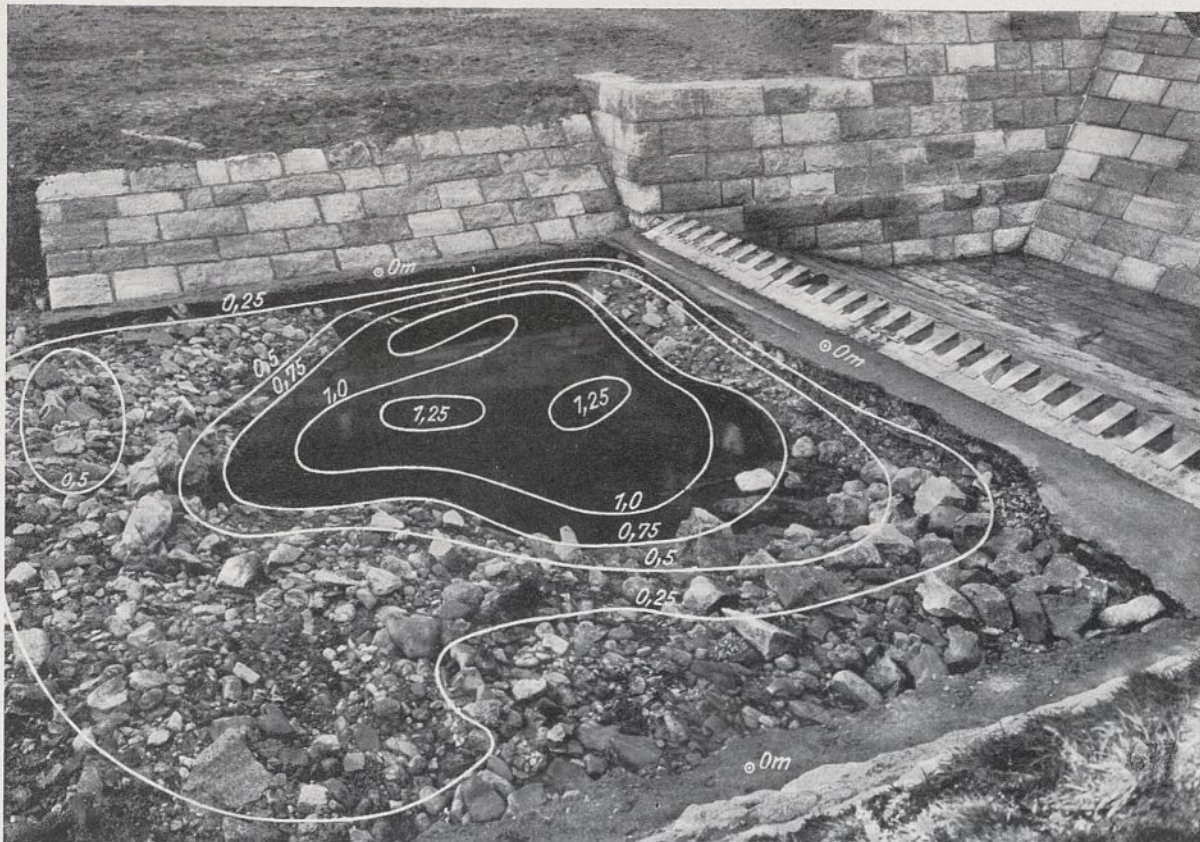
Abb. 2. Zahnschwelle mit Kolken nach der Natur.
