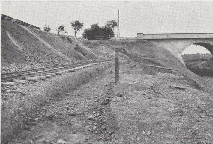
Abb. 18. Das hintere Bohrrohr ist an der Grenze zwischen festem und lockerem Ton umgeknickt (Rutschfläche).
