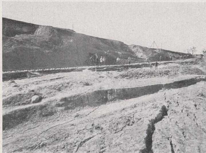
Abb. 28. Konzentrisch verlaufende Risse bei dem Nachrutsch VI am 24. 4. 1926.
