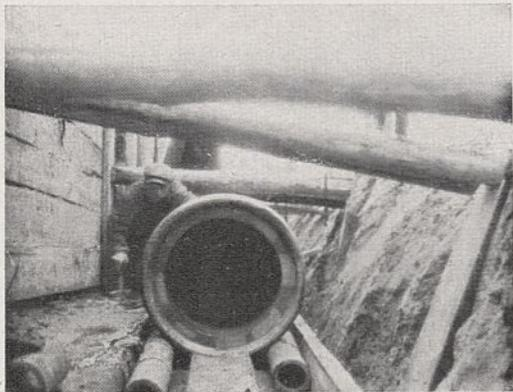
Abb. 50. Einbringen der offenen Betonsohle.
