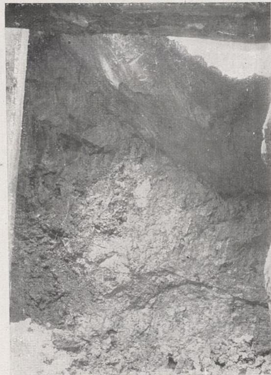
Abb. 24. In der oberen Hälfte die freigelegten Ablösungsflächen im Geschiebelehm.
