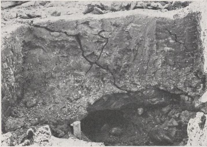
Abb. 22. Senkrechte Gleitflächen in blättrigen Ton am Fuß der Rutschung. Nachrutschung IV vom 22. 5. 1926.
