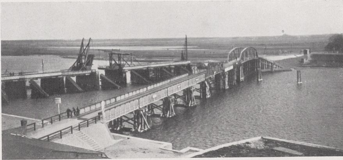
Abb. 5. Behelfsbrücke oberhalb der alten Holzbrücke.
