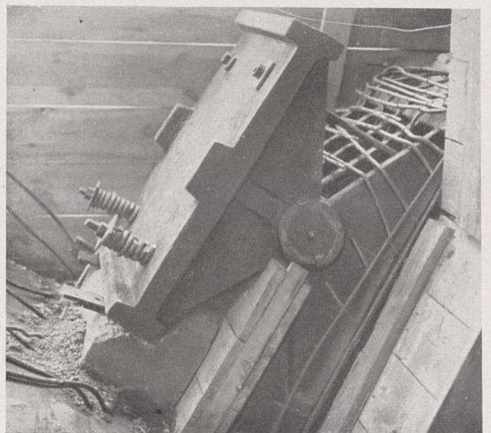
Abb. 8. Kämpfergelenk mit Schutzkapsel über dem Bolzenkopf.
