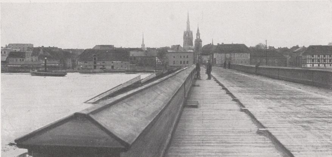
Abb. 4. Fahrbahn der alten Schwedter Holzbrücke.
