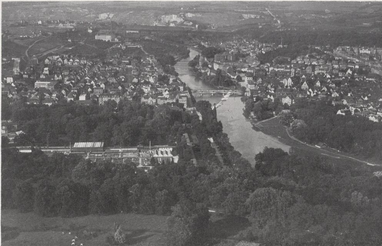
Blick auf Cannstatt mit Wilhelmsbrücke und talab auf Münster.
