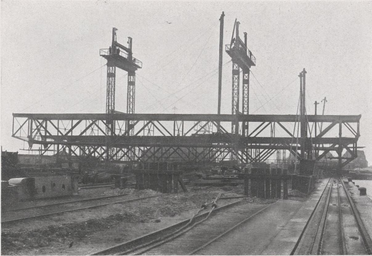
Abb. 52. Aufbau der Eisenverladebrücken.
