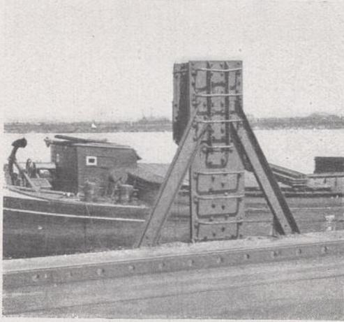
Abb. 15. Stützpunkt für die Abbäumvorrichtung.
