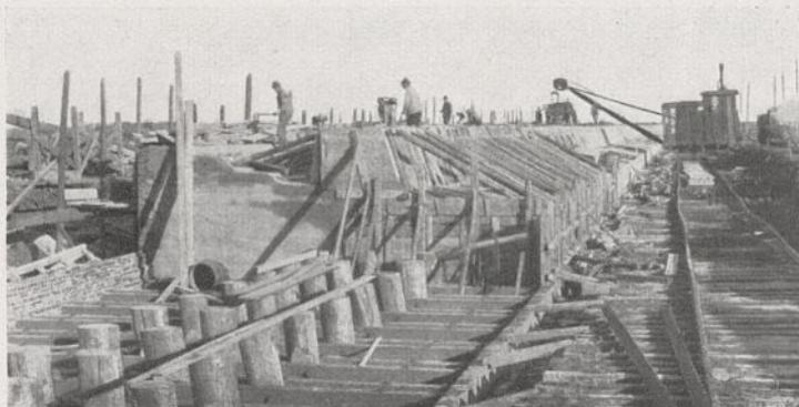
Abb. 9. Dehnungsfuge in der Kaimauer.
