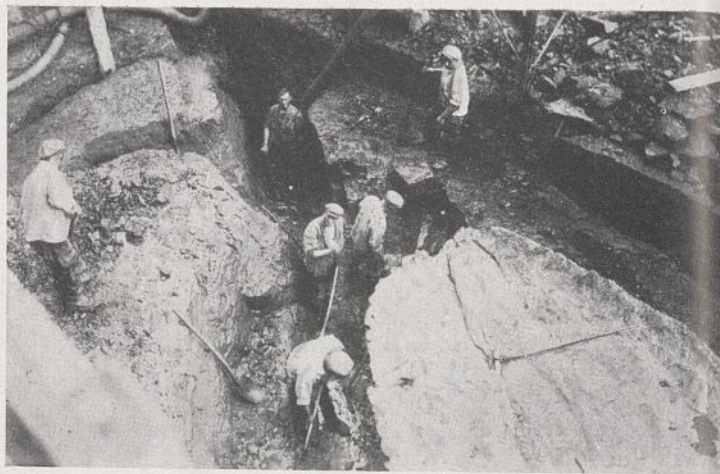
Abb. 51. Ausräumen einer Verwerfungsspalte.
