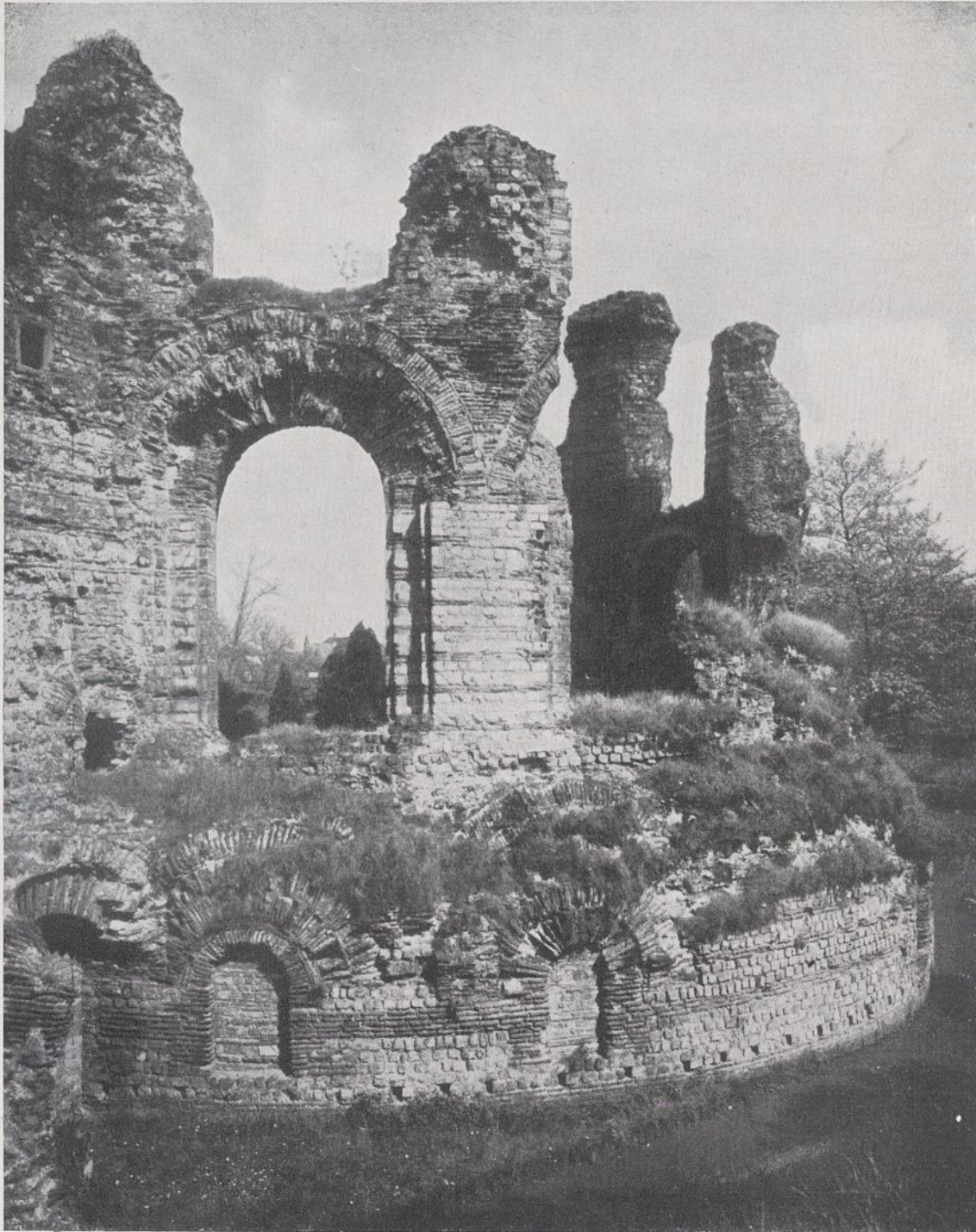
Abb. 1. Blick auf die mittlere Apsis des Caldariums von außen. Aus: „Die Trierer Kaiserthermen“.
