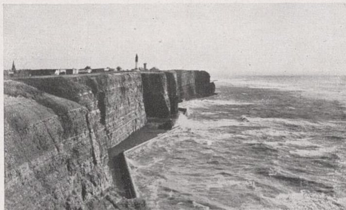
Abb. 42. Fertige Mauer vom Oberland gesehen.
