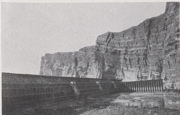
Abb. 56. Fertige Mauer von der Felsseite bei Niedrigwasser.
