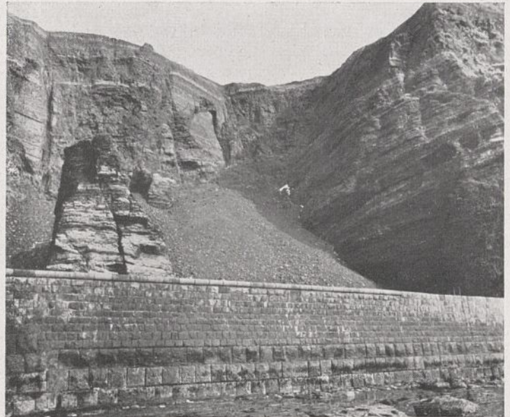
Abb. 41. Absturzhalde hinter der Schutzmauer.
