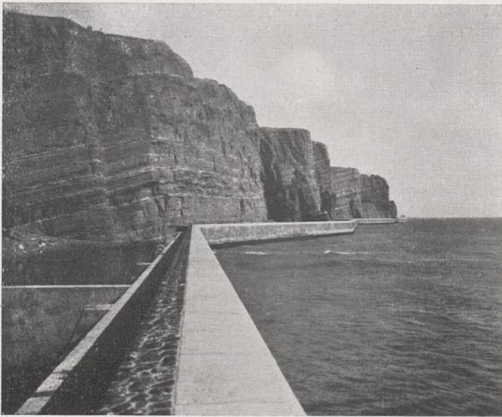
Abb. 40. Die fertige Schutzmauer.
