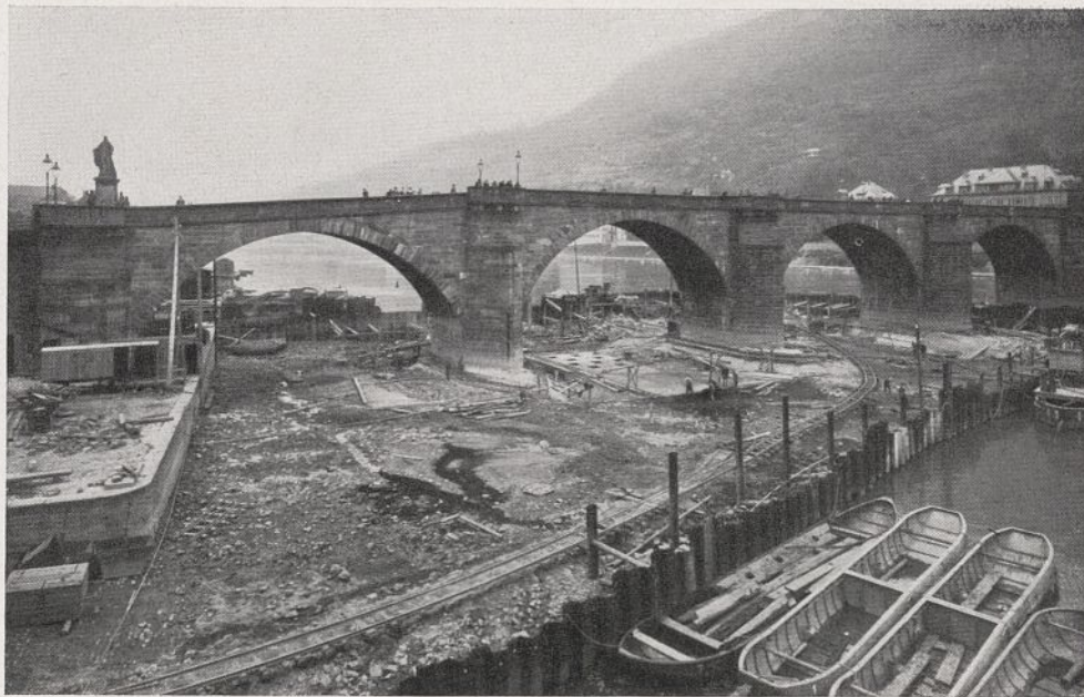
Abb. 9. Staufufe Heidel- berg, Pfeiler- sicherung der Karl- Theodor-Brücke
