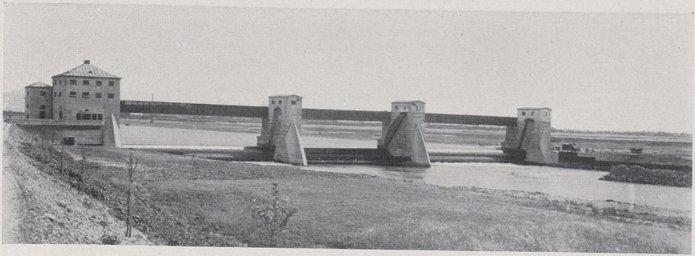
Abb. 4. Staustufe Ladenburg, Wehr mit Wehrkraftwerk vom Unterwasser. Mitwirkender Architekt: Oberbaurat Dr. Schmieder, Heidelberg. Aufnahme der M. A. N.
