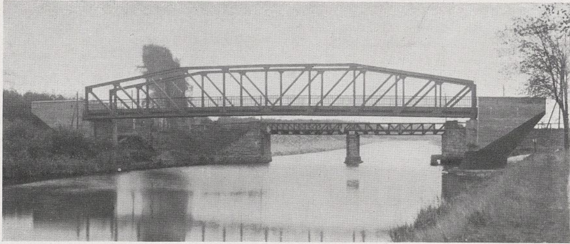
Abb. 15. Kader Brücke im Zuge eines Feldweges unterhalb der Schleuse Kade. Neue und alte Brücke.
