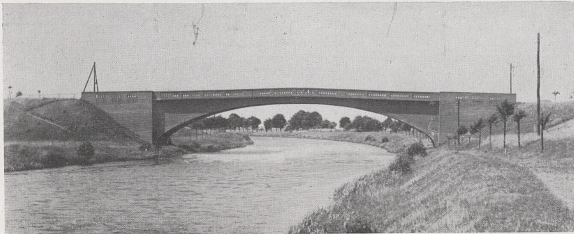
Abb. 11. Klus-Brücke im Zuge des Feldweges Bury-Parchau.
