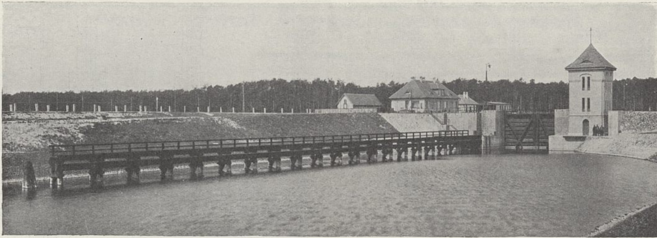
Abb. 22. Wasserkraftwerk am östlichen Flügel des Unterhauptes der Lehnitzschleuse.
