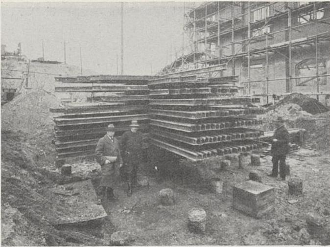
Abb. 7. Probelastung eines Straußpfahles.
