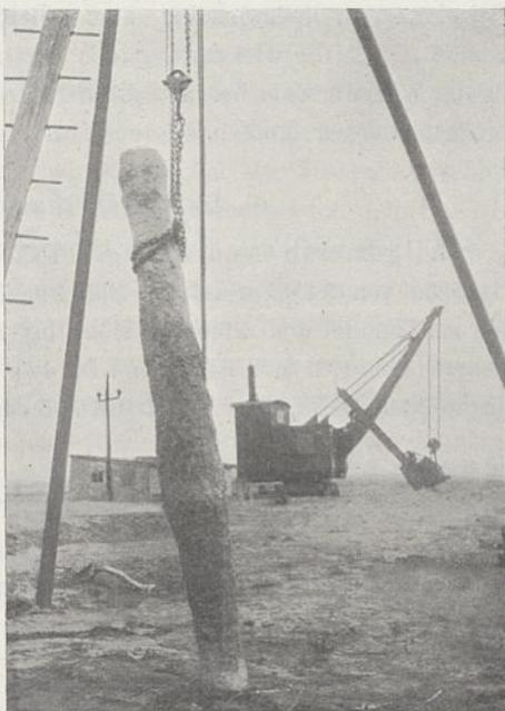
Abb. 8. Ausgegrabener Probelbetonpfahl (Strauß' Bauart).
