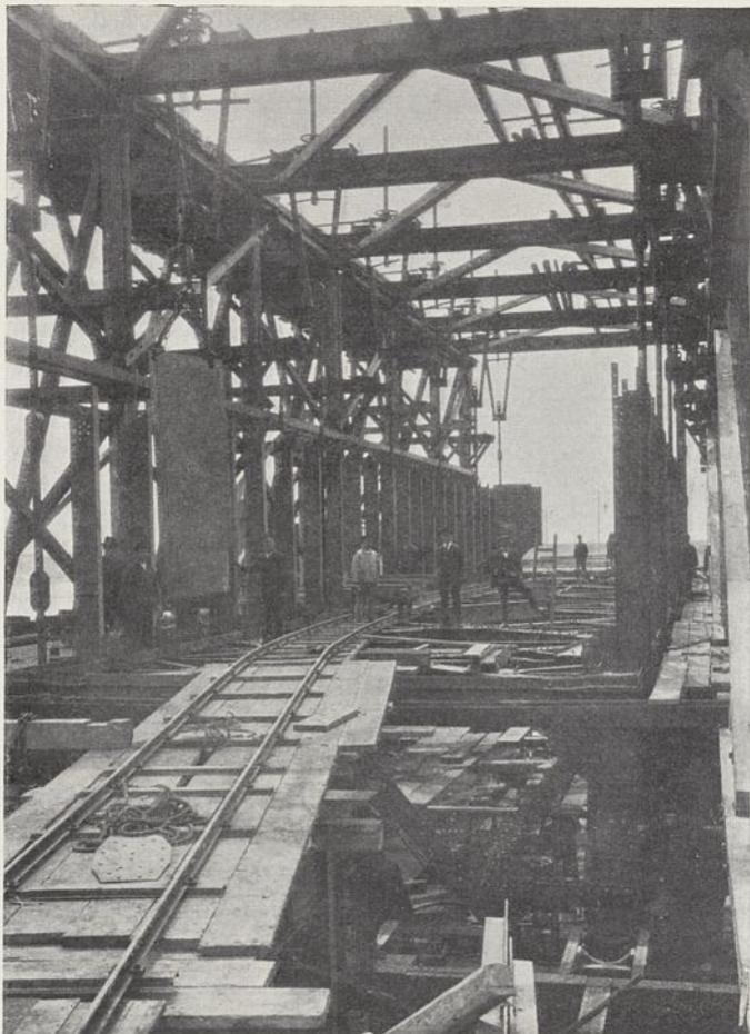
Abb. 27. Torbau oberhalb des Riegels B und Aufhängung.
