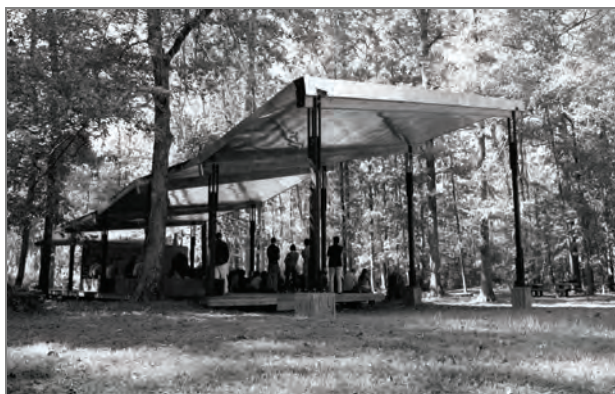
Il. 3. 20K-house v.3. Foto: „On being”.
