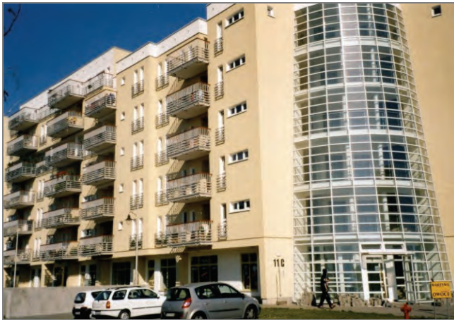
II. 3. Poznań – podkreślenie narożnika budynku poprzez przeszklenie z klatką schodową (fot. autor)
