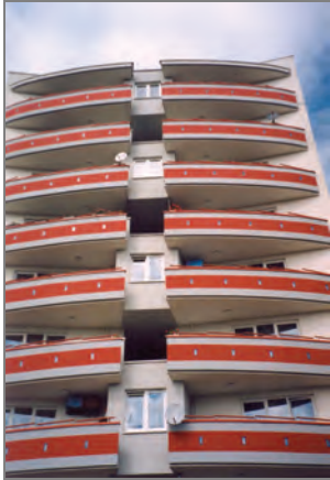
II. 1. Kraków – elewacja frontowa budynku z kontrastowym zestawieniem obudowy balkonów (fot. autor)
