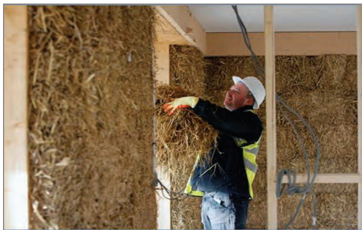
Il. 3. Budowa budynku socjalnego w Waddington, metoda Strawbale.
