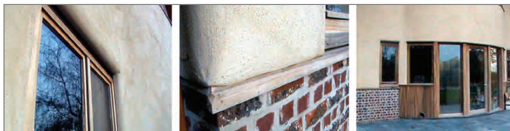
II. 5. Detale budynków strawbale , wapienny tynk zewnętrzny, Belgia 2009, fot. B. Wojtkowska
