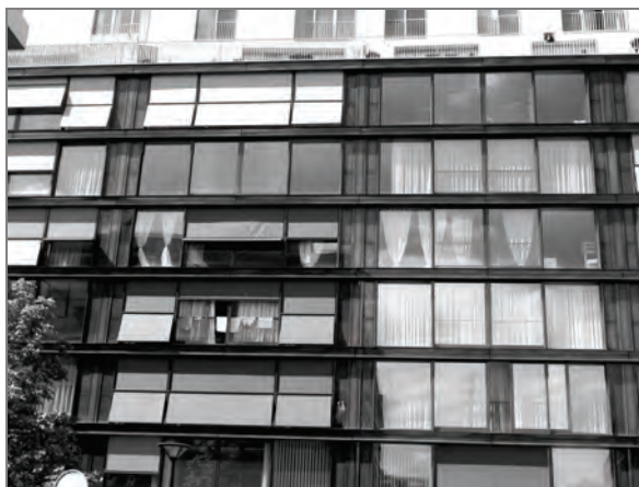
II. 5. Przesuwne okiennice dają efekt zmienności na elewacjach w zespole budynków w Zurychu
