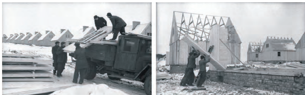
Il. 2. Wznoszenie domów fińskich dla górników kopalni węgla kamiennego w Katowicach (1948). Źródło: http://fdpl.eu/technologie/finskie-drewniane-domy-modulowe-w-polsce-83/ (dostęp: 10.10.2012).
