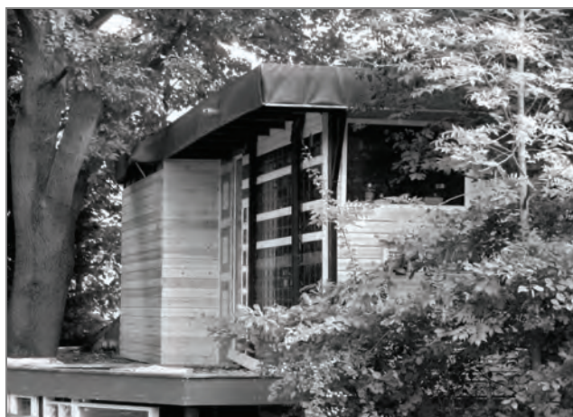
Il. 4. Dom w trakcie rozbudowy, Walters Way, Londyn (fot. Michał Gierszon, 2012)
