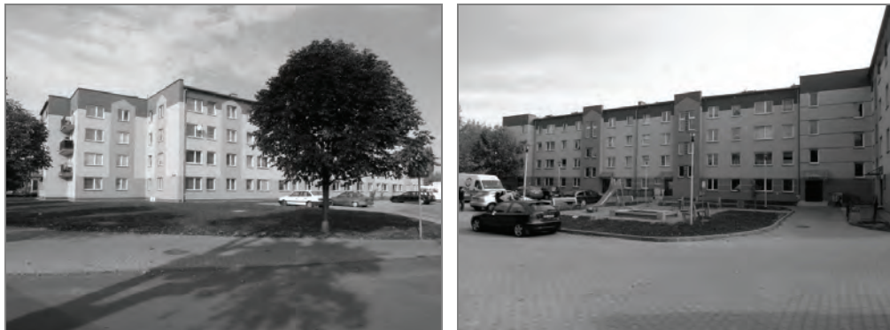
Il. 9, 10. Budynek socjalny przy ul. Kleberga 2a–e w Oleśnicy, fot. autor
