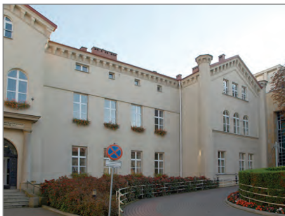
Il. 2. Szpital przy ul. Skawińskiej 8, proj. Antoni Stacherski, 1861, stan obecny, fot. Paweł Koźlik
