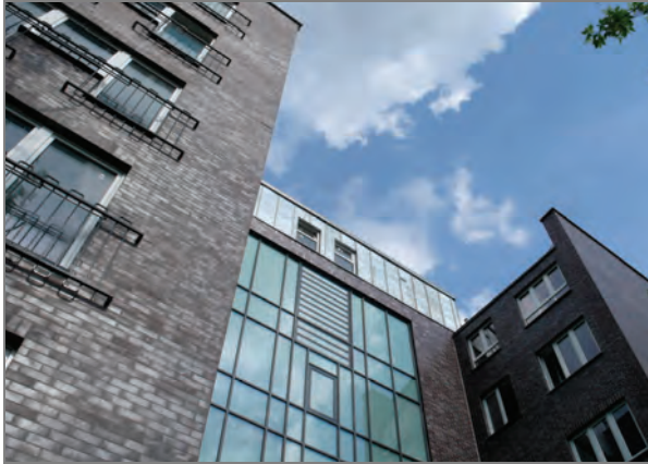
Il. 5. Warszawa – dom nad rozchodnikiem, przeszklenia klatki schodowej (fot. )
