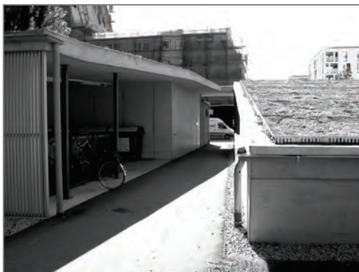
Il. 4. Zielone dachy nad parkingiem dla rowerów i pojemnikami na śmieci w osiedlu w Insbrucku zwiększają powierzchnię biologicznie czynną
