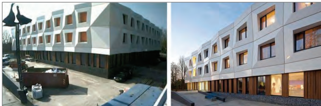
Il. 1. „Veilige Veste”, budynek socjalny Fundacji Fier Fryslân w Leeuwarden (Holandia) opiekującej się młodymi kobietami – ofiarami przemocy, fot. KAW/e architecten, autorzy projektu architektonicznego
