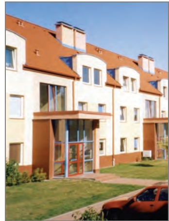
II. 4. Szczecin – przeszklenie wejścia do budynku (fot. autor)
