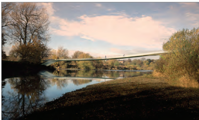
II. 10. Kładka pieszo-rowerowa, Carlisle, UK
