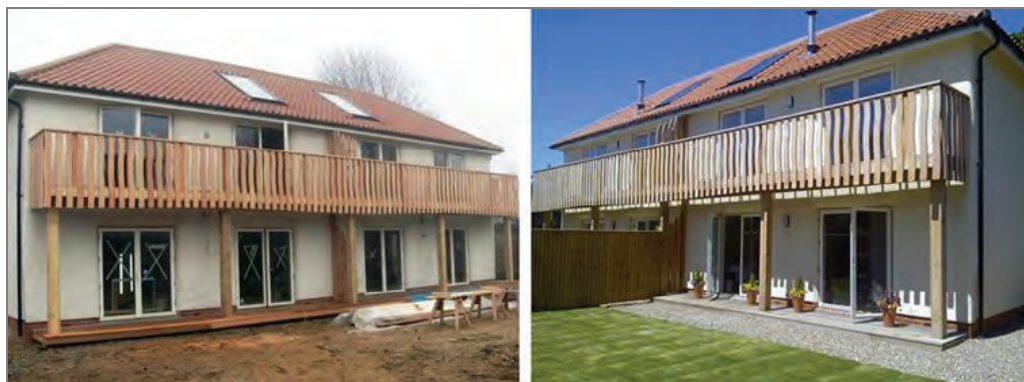
II. 2. Waddington, Dom socjalny po ukończeniu budowy. Źródło: Strawworks, Barbra Jones, Wlk. Brytania, 2012
