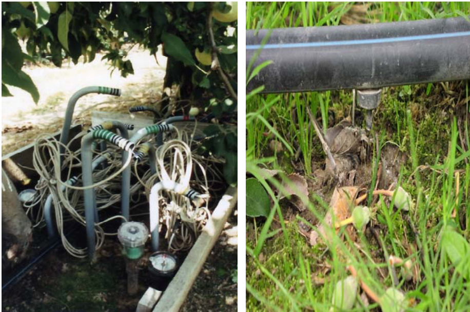
Fot. 3. Stanowisko badawcze gospodarki wodnej gleby nawadnianej kroplowo (str. lewa) w Samotworze; szczegół rurociągu z kroplownikiem (str. prawa)
