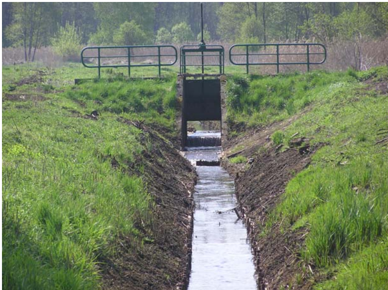
Fot. 6. Zastawka na rowie Phot. 6. Weir on the ditch
