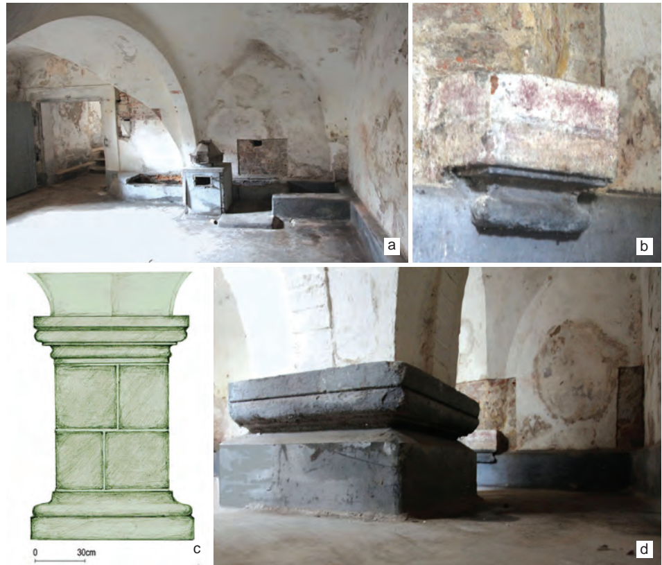
Il. 2. Piwnica z fragmentem dawnego cellarium trzebnickiego w 2015 r.: a – ściana zachodnia, b – wspornik, c – rekonstrukcja północnego lica filara, d – impost filara (oprac. E. Łużyniecka)
