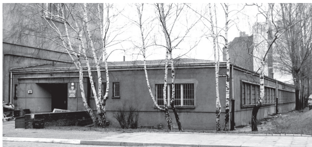
Il. 1. Wrocław, ul. Łukasiewicza, pawilon laboratoryjny Wydziału Mechanicznego, budynek niezachowany (proj. A. Frydecki) (fot. R. Makowski, Archiwum Politechniki Wrocławskiej, sygn. 329/35, AB 22.1)
