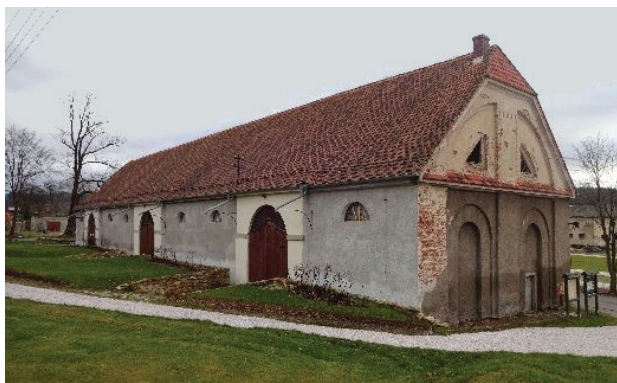
Il. 5. Bukowiec, wyremontowana stodoła (fot. A. Marcinów, 2015)
