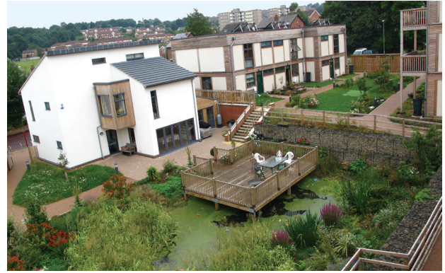
Il. 1. Osiedle LILAC co-housing z domem wspólnotowym po lewej – jedno z dwóch studiów przypadku projektu BuPESA (fot. M. Baborska-Narożny)
