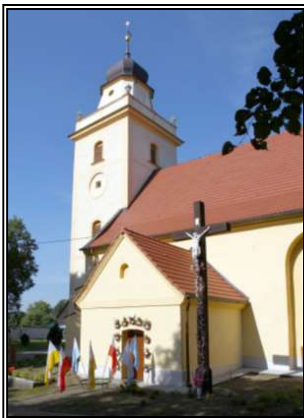
Fot. 3.4.11. Widok zewnętrzny kościoła pod wezwaniem św. Michała Archanioła w Sobinie, 2013 rok (fot. autor pracy)
