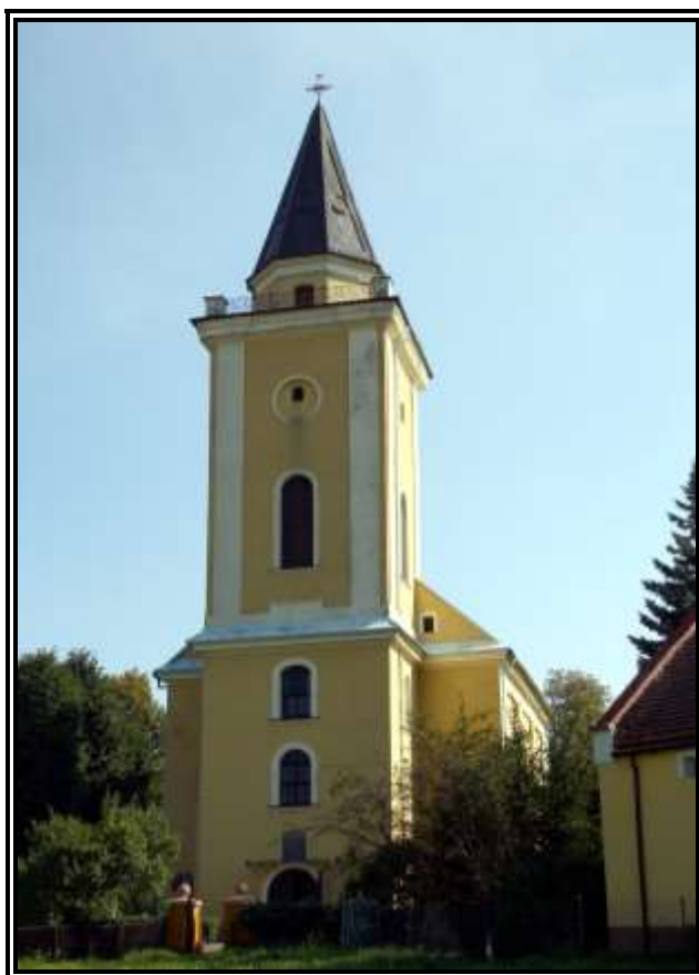
Fot. 3.4.3. Widok zewnętrzny kościoła pod wezwaniem św. Urszuli w Gwizdanowie 2013 rok (fot. autor pracy)
