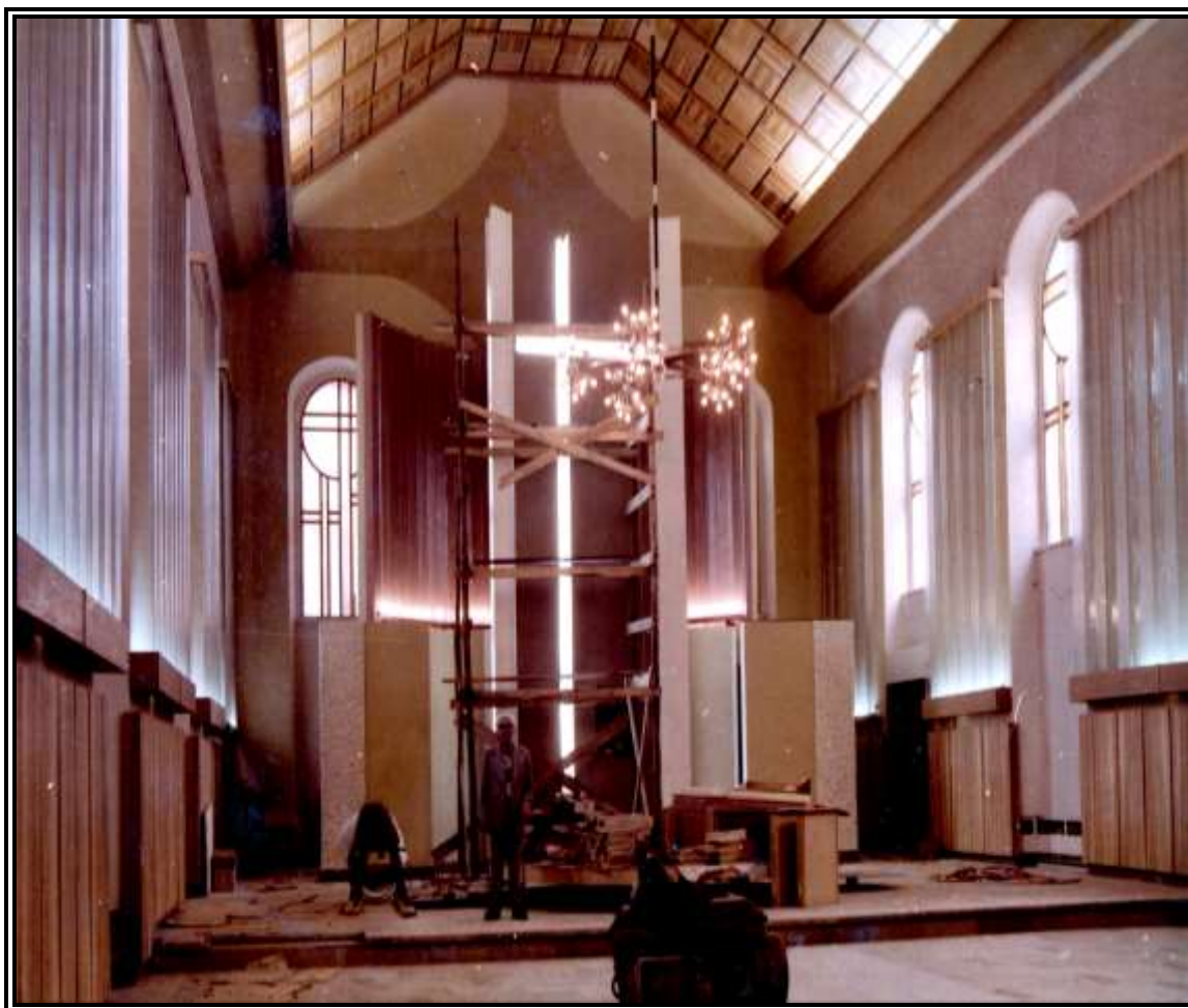
Fot. 3.1.9. Wnętrze kościoła św. Barbary pod koniec remontu w 1979 roku (fot. archiwum parafii pod wezwaniem św. Michała Archanioła w Polkowicach)
