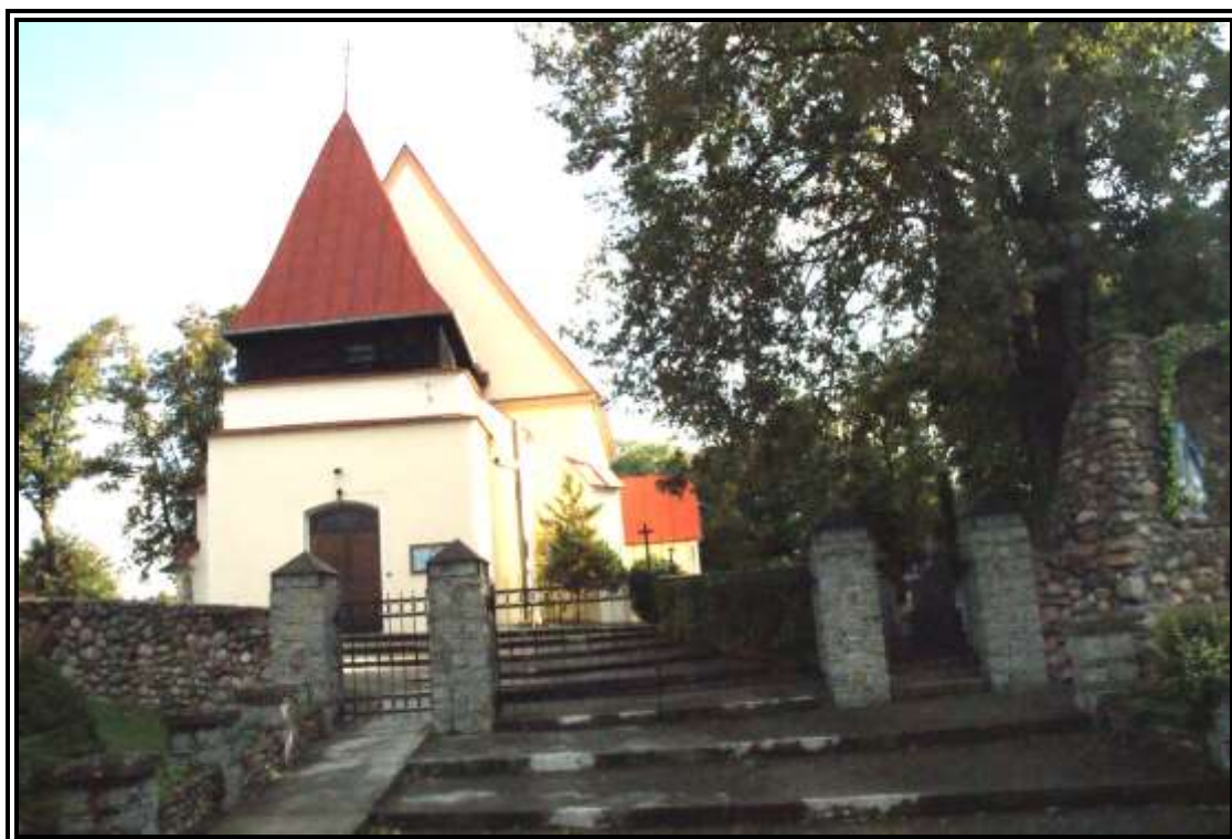
Fot. 3.4.1. Widok zewnętrzny kościoła pod wezwaniem św. Urszuli w Gwizdanowie 2013 rok (fot. autor pracy)
