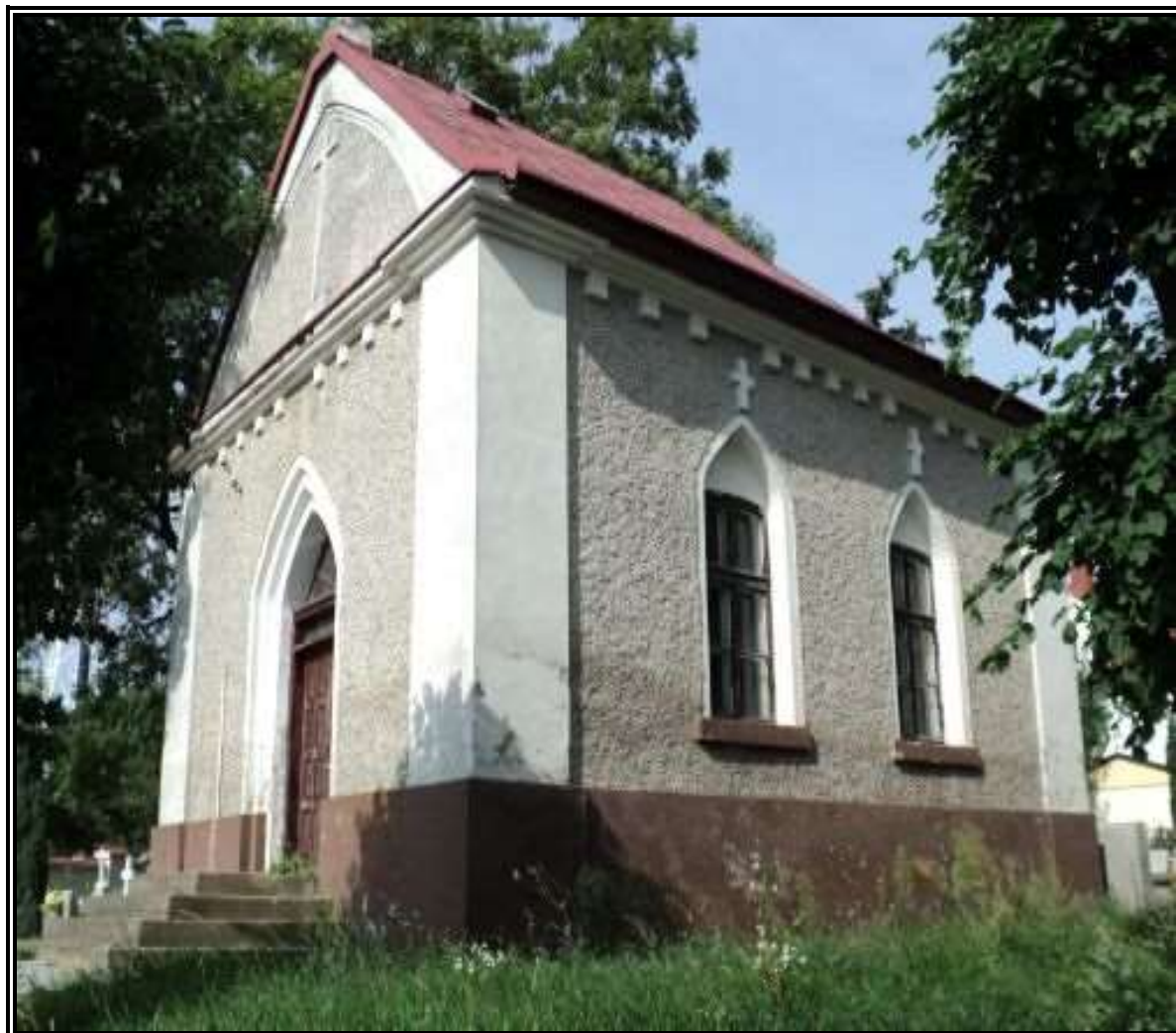
Fot. 3.1.1. Obecny wygląd kaplicy cmentarnej na cmentarzu parafialnym w Polkowicach (fot. autor pracy)
