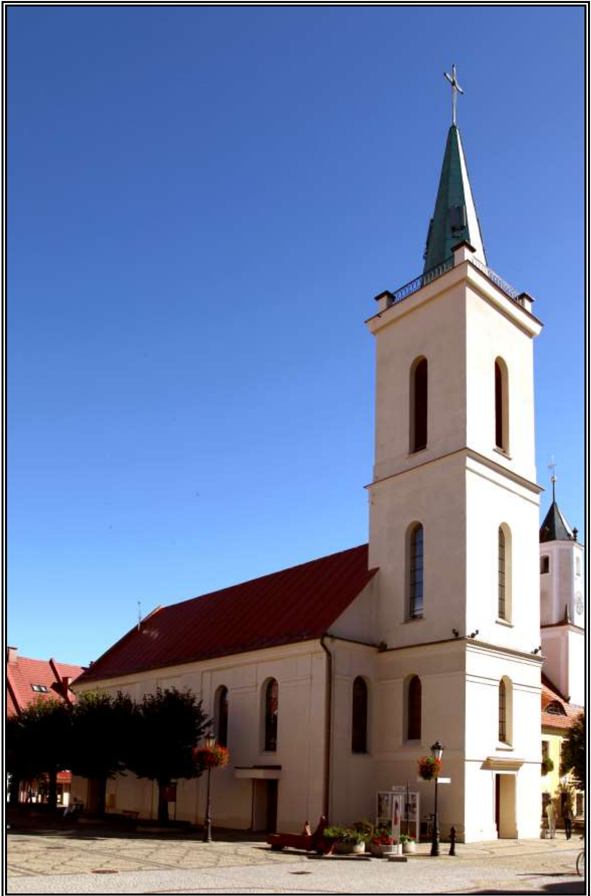
Fot. 3.1.11. Kościół św. Barbary w Polkowicach w 2013 roku (fot. autor pracy)
