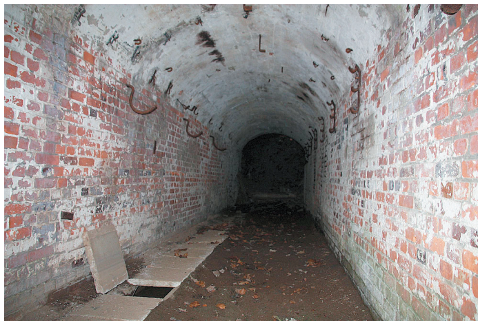
Ryc. 11. Ceglana obudowa wylotu sztolni głównej (fot. K. Maciejak). Fig. 11. Brickwork lining of the main drift entry (picture by K. Maciejak)
