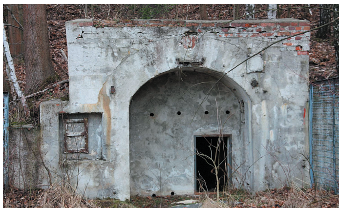
Ryc. 6 Wejście do sztolni według stanu na wiosnę 2016 r. (fot. K. Maciejak) Fig. 6 Mine entry in the spring of 2016 (picture by K. Maciejak)
