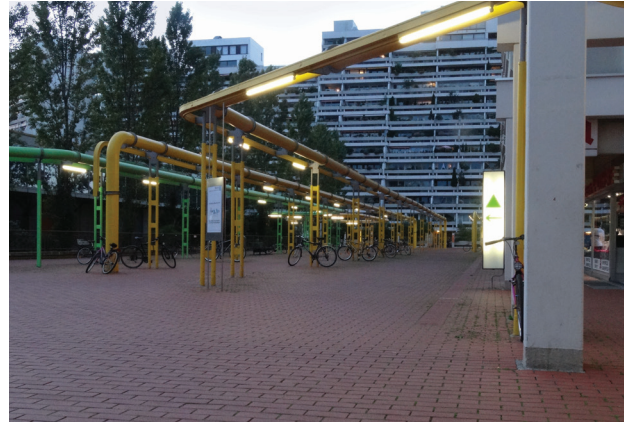
Il. 3. Hans Hollein, Media Linien, Monachium, Niemcy, 1972 (fot. A. Serafin) Fig. 3. Hans Hollein, Media Linien, Munich, Germany, 1972 (photo by A. Serafin)
