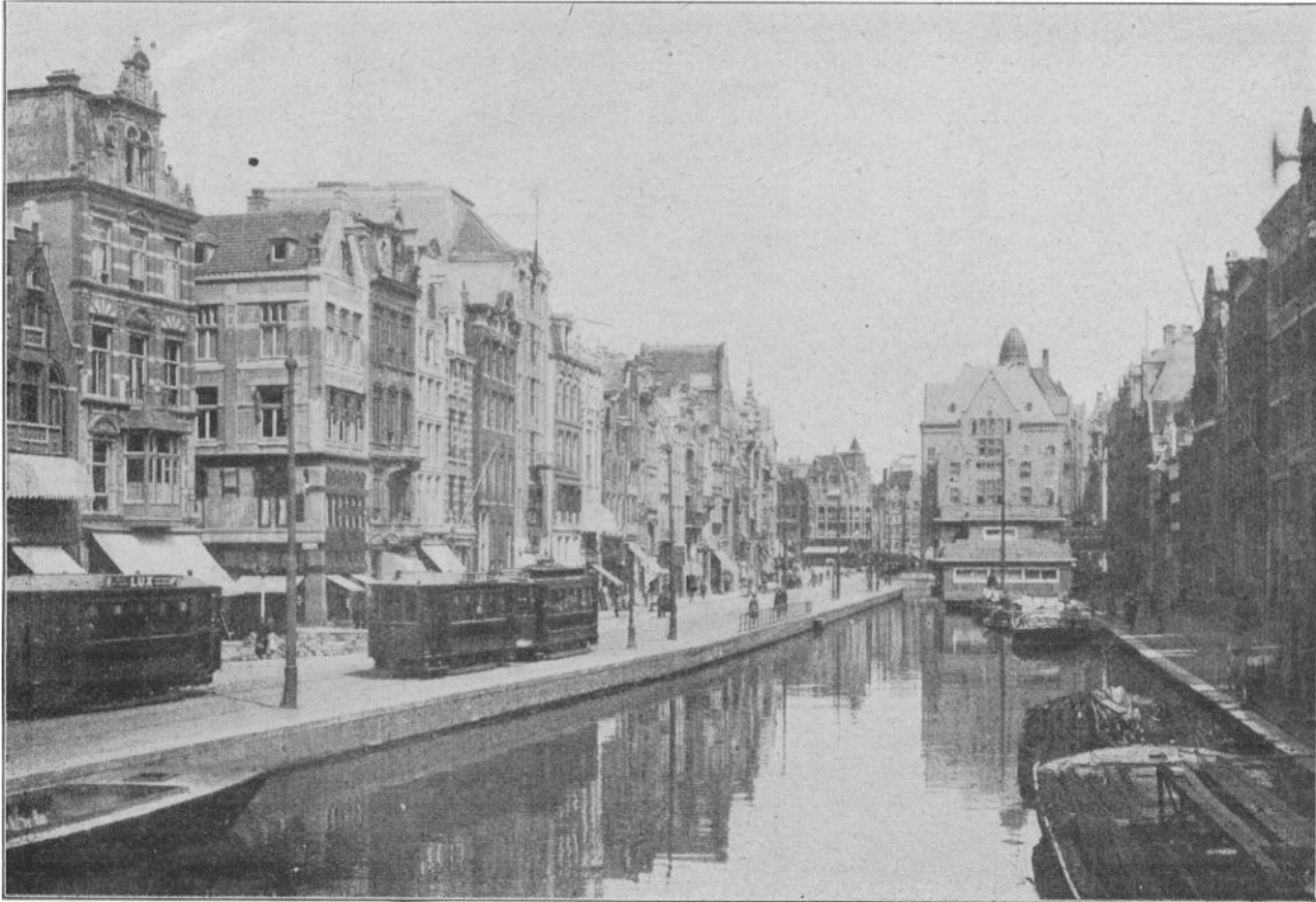
Abb. 4. — Straßenbahn, einen Kanalenlanggeführt, unter dessen Ufermauern der Sand der Straße hindurchfließt.
