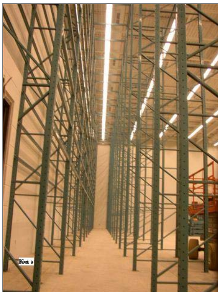
Fot. 2. Konstrukcja regałów
