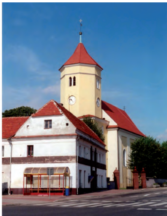
Fot. 3. Kościół katolicki przy rynku w Przemkowie Phot. 3. The Catholic church at market square in Przemków
