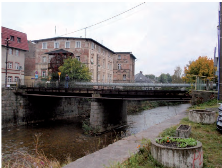
Fot. 52. Rura ciepłociągu przeprowadzona przez rzekę Kamienną w Cieplicach Zdroju Phot. 52. The pipe of central heating system at the Kamienna River bridge in Cieplice Zdrój
