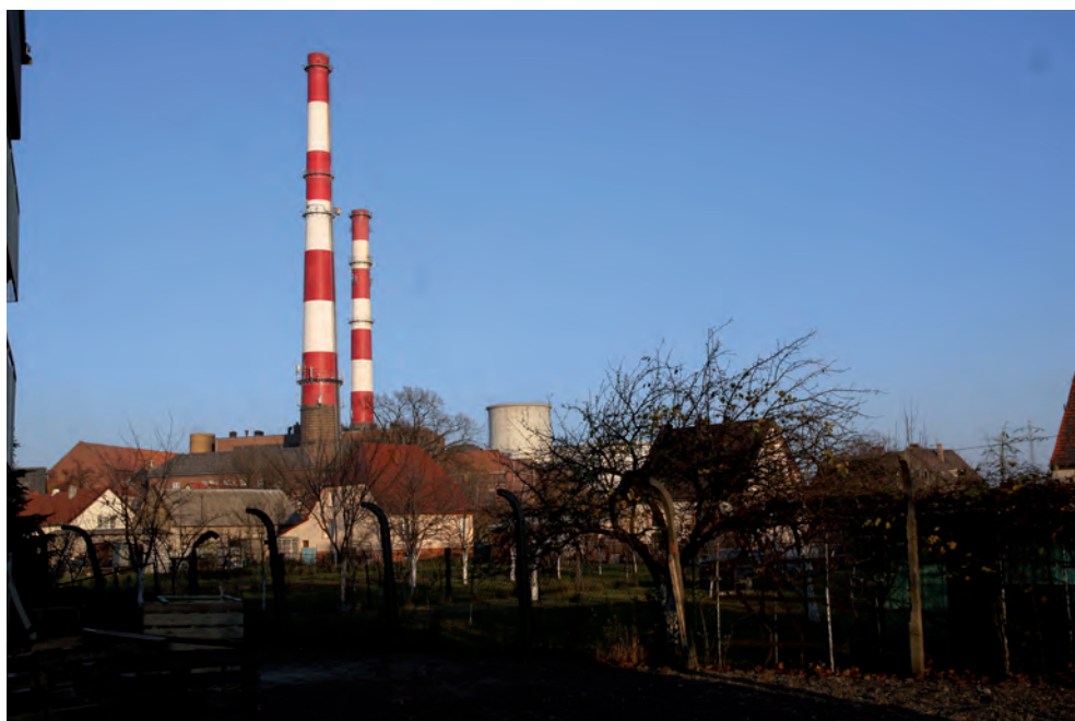
Fot. 65. Kominy elektrociepłowni w Siechnicach jako współczesne dominanty Phot. 65. Chimneys of electro-thermal power station in Siechnice as the contemporary dominants
