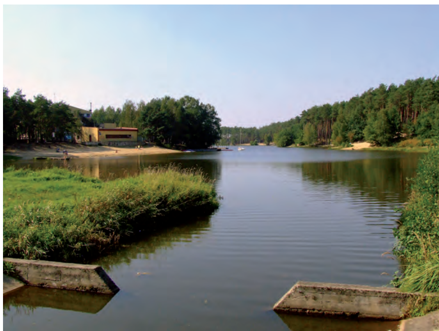
Fot. 57. Widok zbiornika wodnego w Kobylej Górze Phot. 57. View of the storage reservoir in Kobyla Góra
