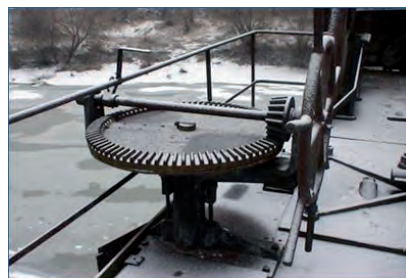
Fot. 44. Fragment urządzeń portowych w Malczycach Phot. 44. Fragment of port constructions in Malczyce
