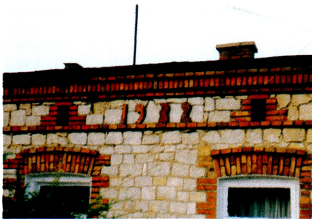
Ryc. 2. Data eregowania na budynku w Kiedrzyń, obecnie Częstochowa, ul. Narcyzowa
