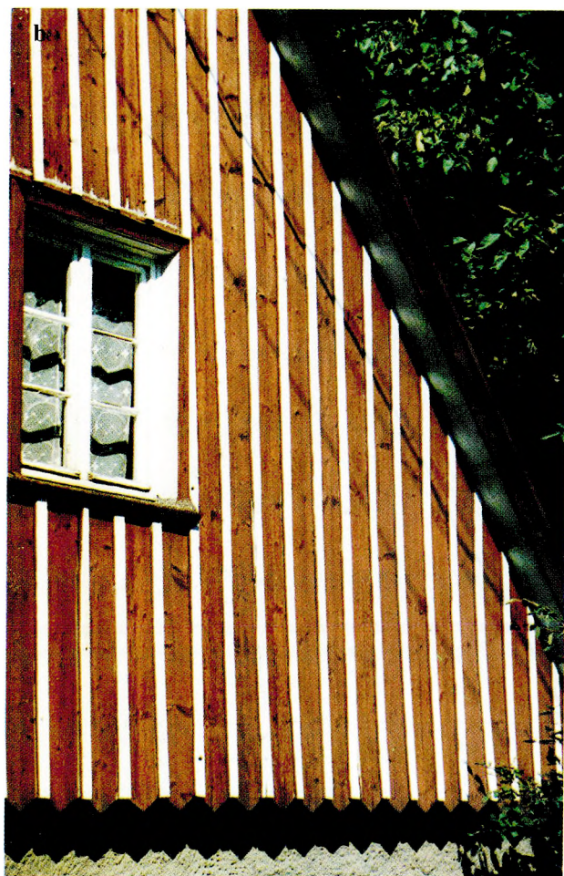
Ryc. 7. Deskowanie ścian szczytowych (z listwami uszczelniającymi) w rejonie Kotliny Kłodzkiej: a) Trzebieszowice, b) Jeleniów, c) Międzygórze, d) Różanka (fot. autorki)
