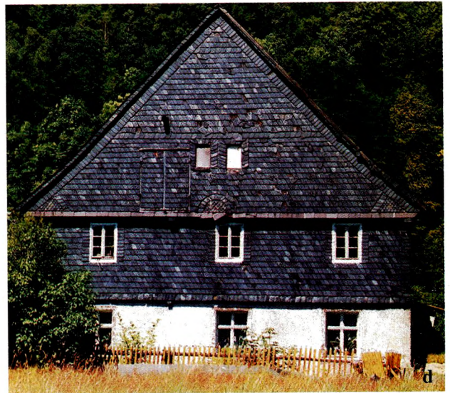
Ryc. 8. Ściany szczytowe opierzone łupkiem: a, c-e) Świeradów, b) Olszyna Lubańska (fot. autorki)
