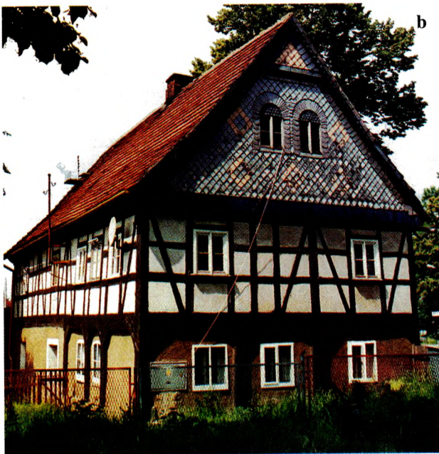
Ryc. 8. Ściany szczytowe opierzone łupkiem: a, c-e) Świeradów, b) Olszyna Lubańska (fot. autorki)
