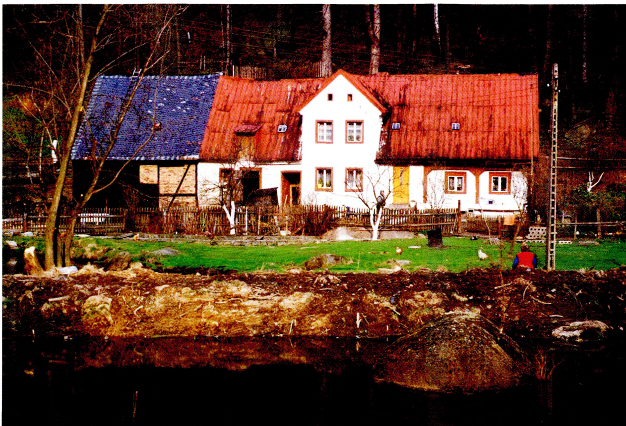
Ryc. 1. Kolorystyka chałupy o konstrukcji mieszanej: ściany przysłupowe w części mieszkalnej, murowane sieni, ryglowe części gospodarczej, odeskowane części składowej, Staniszków k. Jeleniej Góry (fot. autorki)
