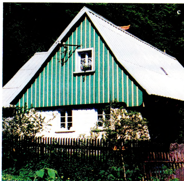
Ryc. 7. Deskowanie ścian szczytowych (z listwami uszczelniającymi) w rejonie Kotliny Kłodzkiej: a) Trzebieszowice, b) Jeleniów, c) Międzygórze, d) Różanka (fot. autorki)
