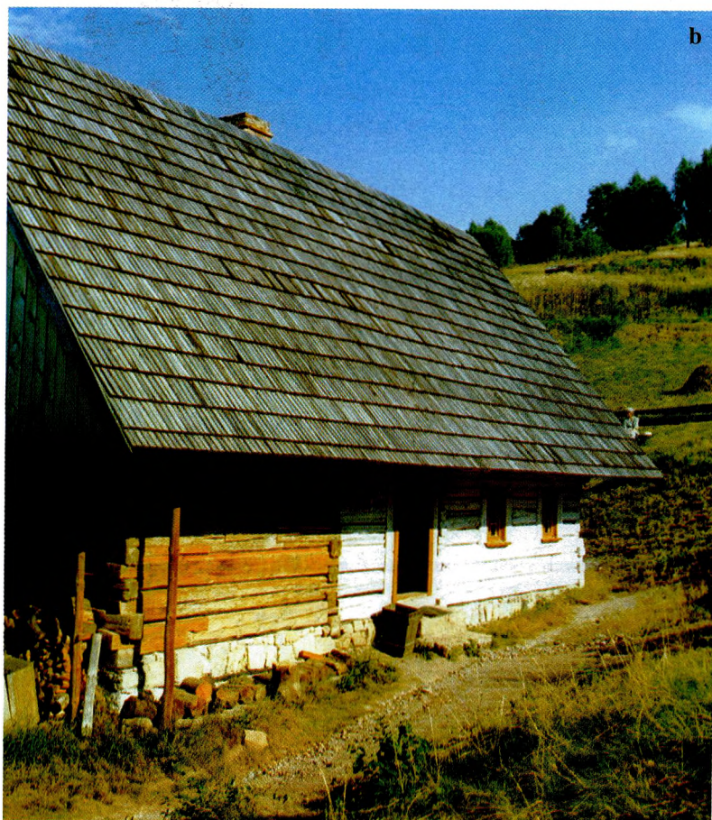
Ryc. 3. Chałupy wieńcowe kryte gontem (skansen Pstrązna): a) karczma z XVIII w., b) chałupa wieńcowa z XVIII w., c) detal (fot. autorki)
