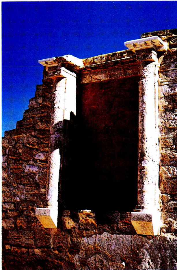
Ryc. 8. Nisza po konserwacji i częściowej rekonstrukcji
