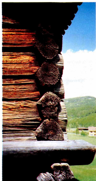
Ryc. 6. Zagroda Tråen w Rollag w rejonie Flesbergu w Dolinie Numedal z XV–XVIII w.: a) parterowy wieńcowy spichlerz ( stabbur ) (po lewej) i typowy spichlerz piętrowy bur + loft o konstrukcji stave , b) detal ściany wieńcowej, c) drzwi do spichlerza, d) narożnik spichlerza (konstrukcja stave )
