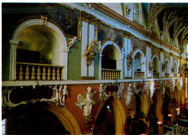
Ryc. 3. Elewacja północna nawy głównej
