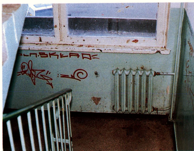
Ryc. 3. Klatka schodowa w bloku na Osiedlu Sobieskiego Fig. 3. Sobieski – staircase in an apartment block
