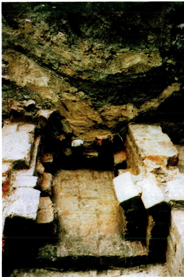
Ryc. 25. Wlot do komory paleniskowej pieca z zamku krzyżackiego w Pucku
