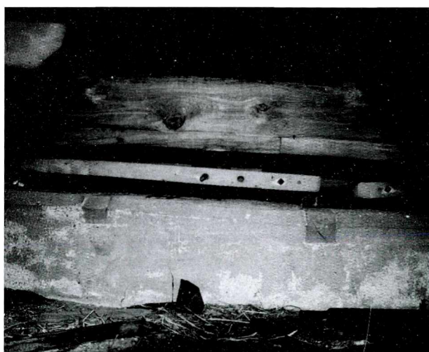
Ryc. 9. Fragmenty fundamentu wraz z szyną oraz konstrukcją nośną paltraka w Strzyżewie
