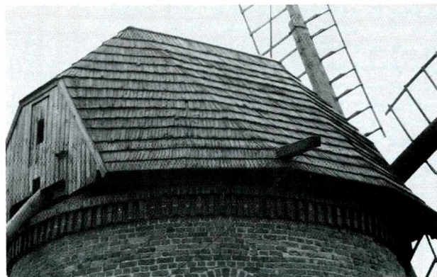
Ryc. 8. Obrotowa głowica wiatraka – holendra w Dziekanowicach Fig. 8. Rotative windmill head – Dutch type, Dziekanowice
