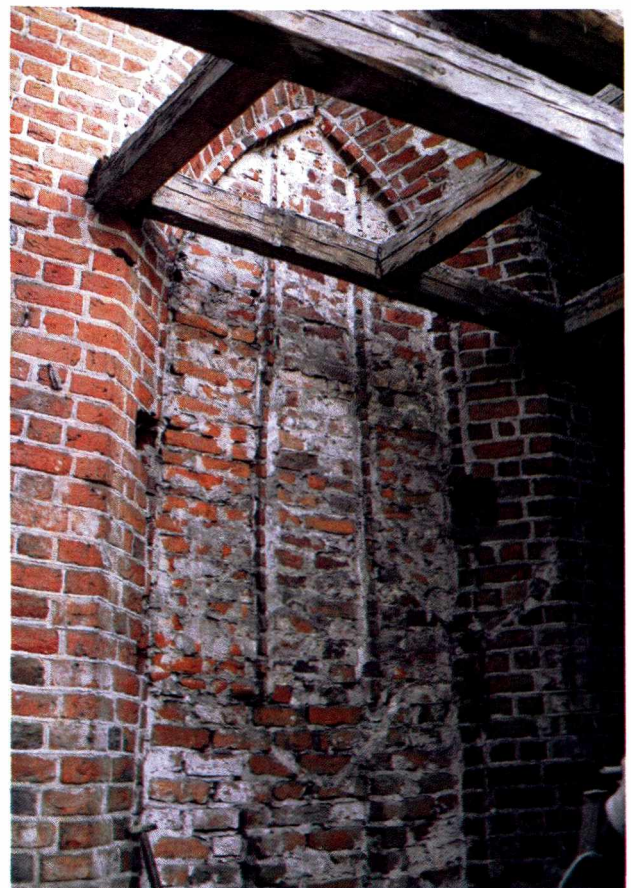
Ryc. 7. Zamurowane okno w ścianie południowej korpusu z zachowanymi laskami podziału, fragmentem tynku w podłuczcu i śladem dachu pograżonego kaplicy
