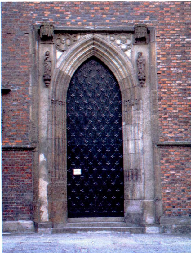
Ryc. 3. Kościół św. Marii Magdaleny, portal zachodni – stan istniejący
