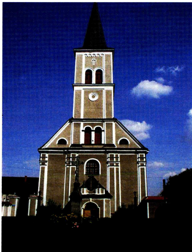
Ryc. 4. Elewacja zachodnia kościoła Fig. 4. West elevation of the church
