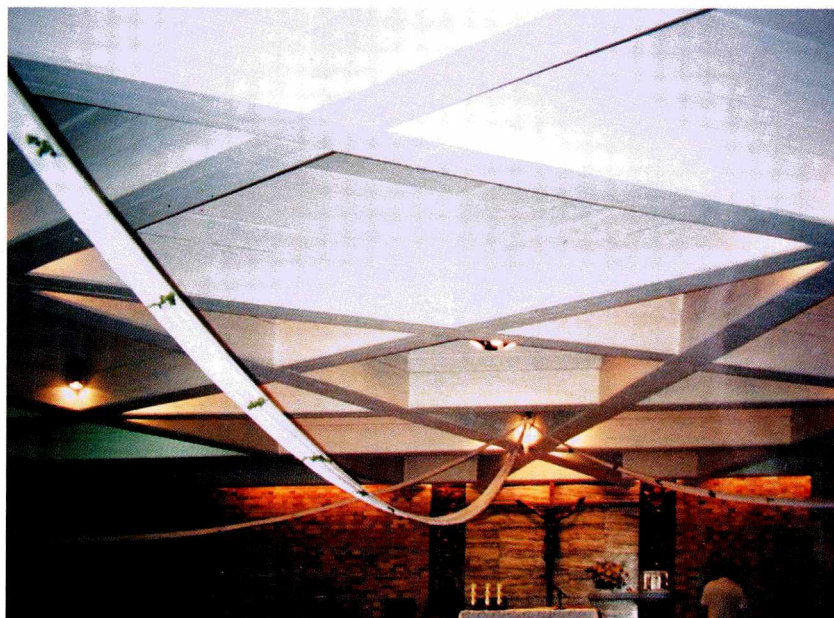
Ryc. 4. Widok konstrukcji stropu w kościele dolnym Kościoła pw. św.św. Barbary i Józefa Robotnika w Zgorzelcu
