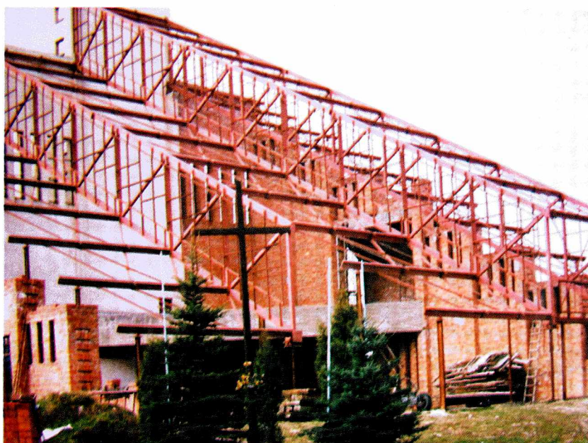
Ryc. 6. Widok konstrukcji dachu nawy głównej kościoła pw. św. Brata Alberta w Sędziszowie
