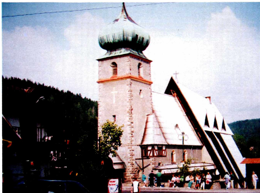
Ryc. 8. Widok kościoła pw. Nawiedzenia Najświętszej Marii Panny w Karpaczu, projekt arch. – Antoni Bil, projekt konstrukcji – Wojciech Marszałek, realizacja w latach 1979–1981
