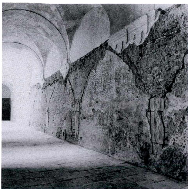
Ryc. 2. Ściana północna krużganka północnego (1) i odkryty w jej licu wspornik W5 (2), 2003 r.
