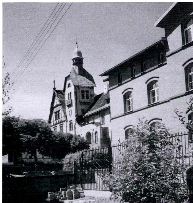
Ryc. 15. Osiedle przy ul. Beethovena. Widok dawnej restauracji z podwórza budynku nr 10
