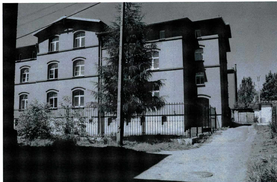
Ryc. 14. Ul. Beethovena 10. Budynek ocieplony z zewnątrz Fig. 14. 10 Beethoven street. Building made warmer from the exterior
