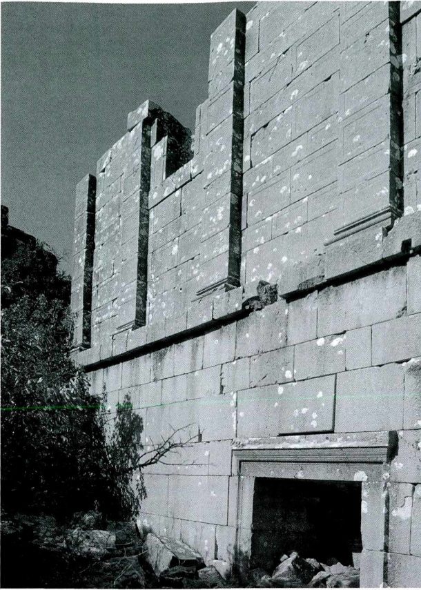
Ryc. 2. Termessos – bouleuterion, fragment elewacji wejściowej
