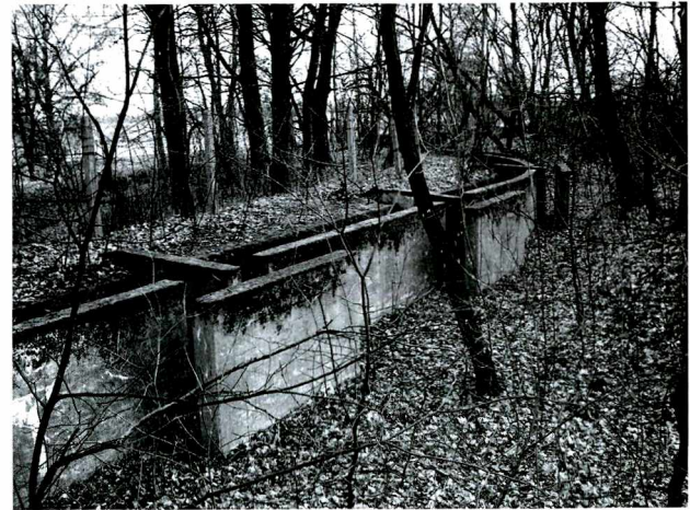
Ryc. 8. Żelbetowe stanowiska strzeleckie na terenie IST 6
