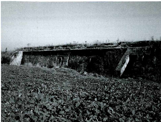
Ryc. 7. Elewacja szyjowa schronu mobilizacyjnego
