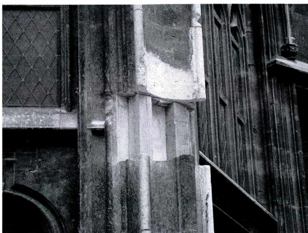
Ryc. 1. Demontaż uszkodzonego elementu kamiennego
