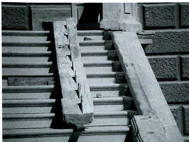
Ryc. 8. Izolacja żywicą epoksydową Fig. 8. Epoxy resin insulation
