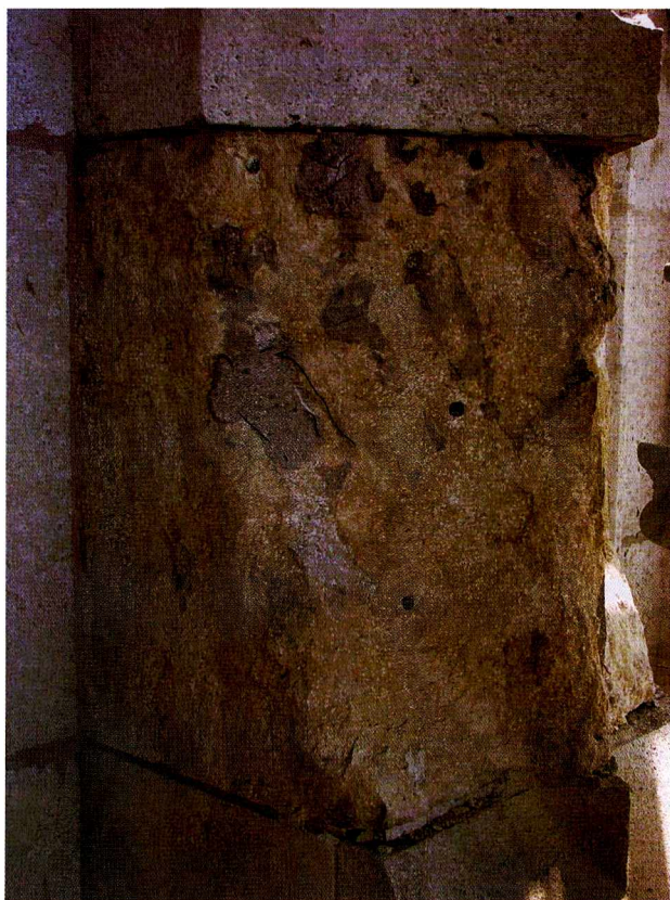
Ryc. 10. Rozsadzanie pierwotnego materiału przez plomby cementowe Fig. 10. Splitting of the original material by cement filling
