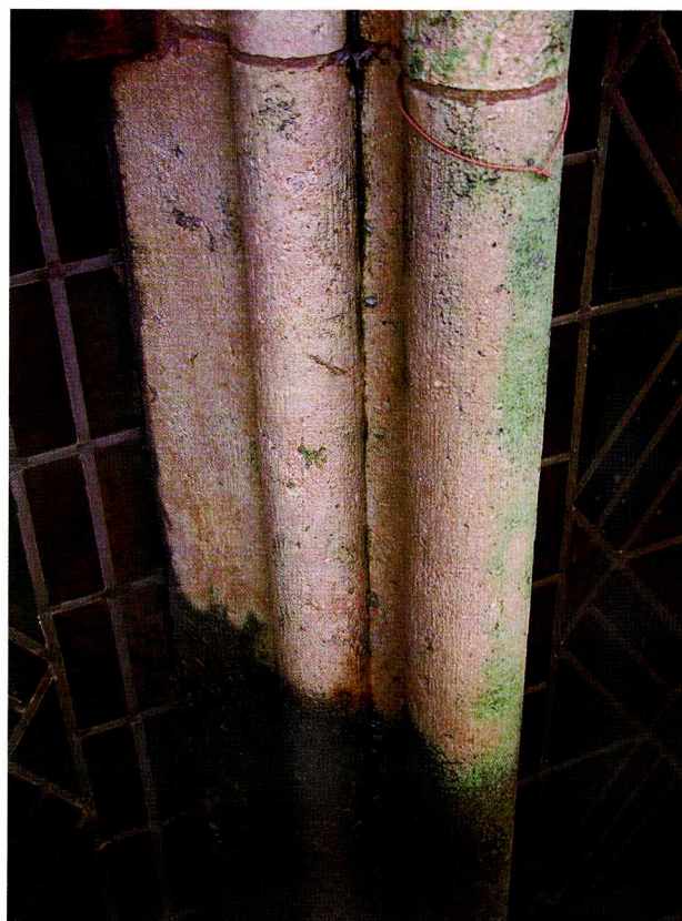
Ryc. 11. Przykład oczyszczanego elementu Fig. 11. Example of cleaned element
