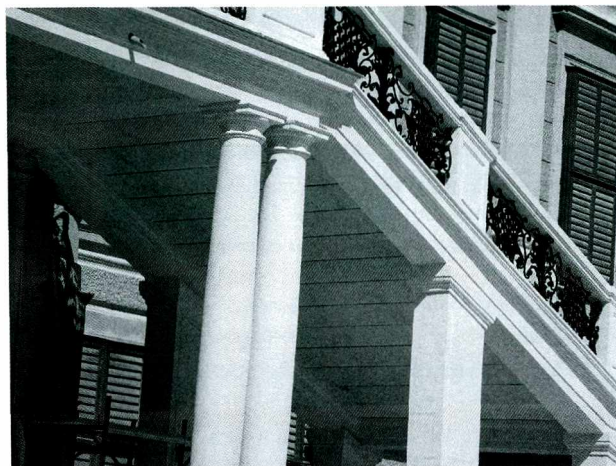
Ryc. 7. Podwójne słupy podtrzymujące podesty i biegi zostały wzmocnione i zakonserwowane Fig. 7. Double pillars supporting landings and courses have been strengthened and preserved
