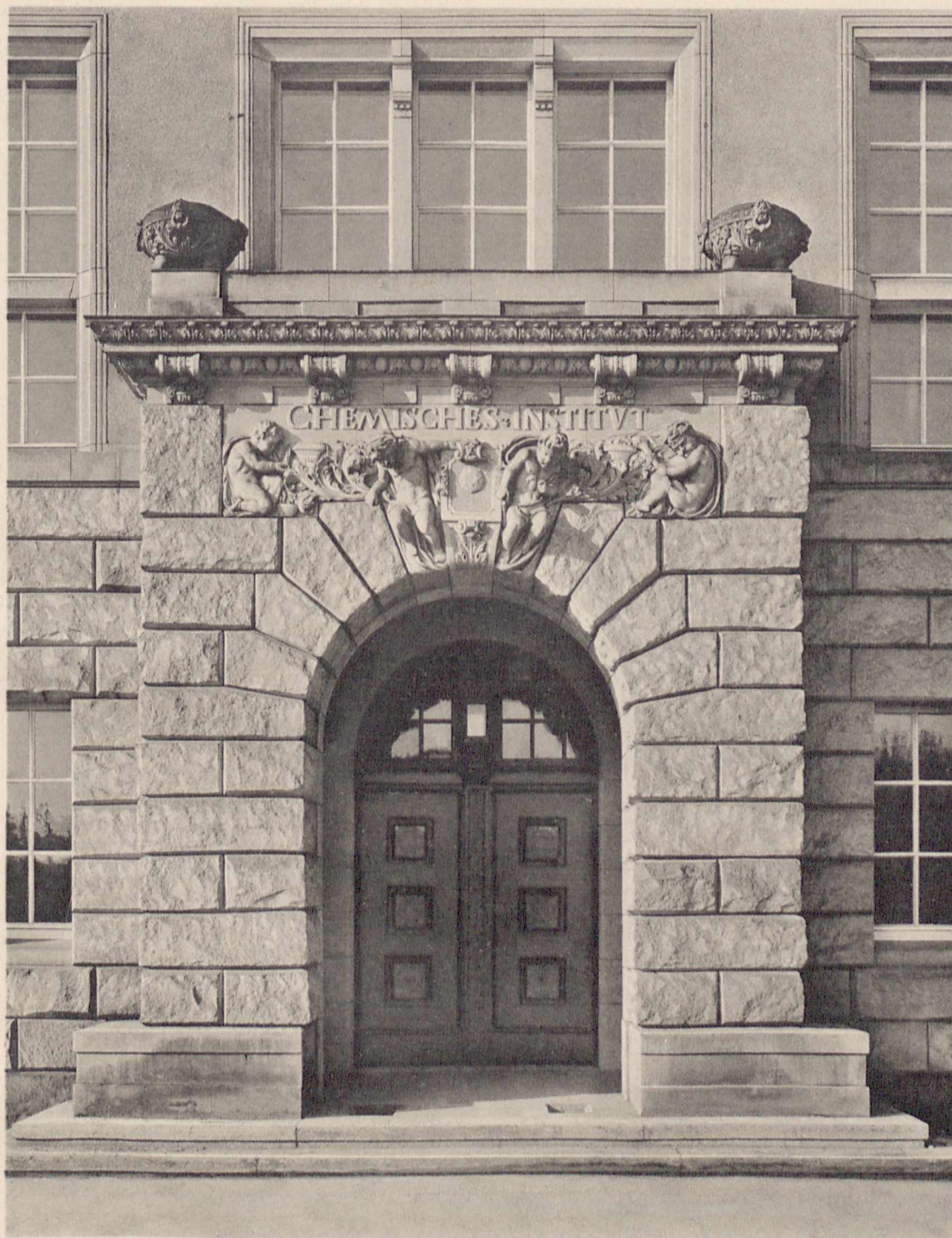
Chemisches Institut, Hauptportal.
