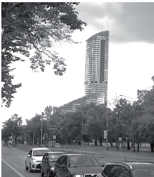
Figure 1. Sky Tower – view from Powstańców Śląskich Street
