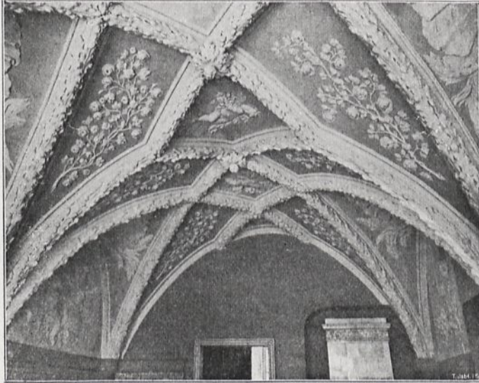
Stiuki na sklepieniu w domu I. I przy ulicy Szczepańskiej (dzieło Baltazara Fontany).
