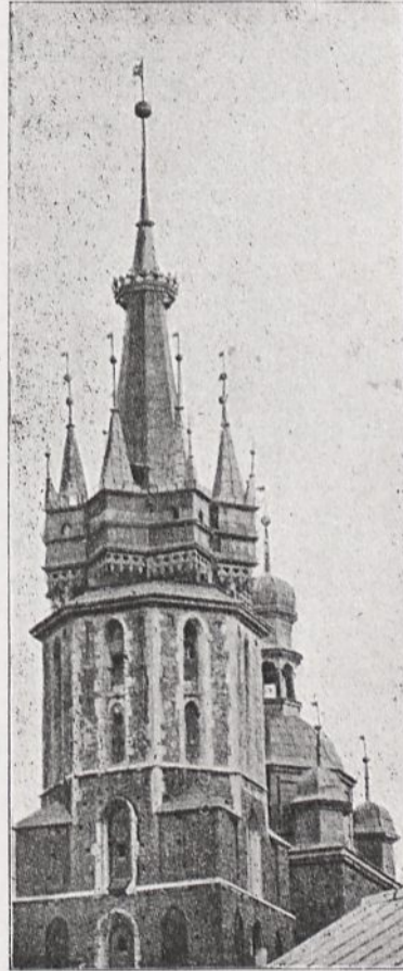
Szczyt wieży Maryackiej (Strażnica ogniowa).
