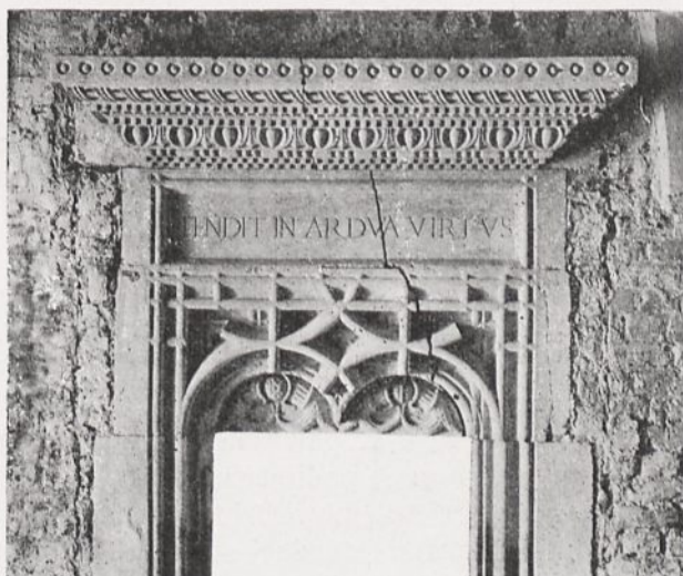
Drzwi w salce na I piętrze.
