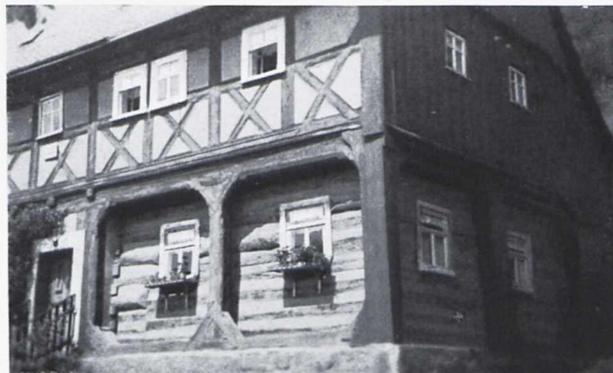
Abb. 138. Überstehendes Oberfachwerk. Schwelle unter den Säulen mit Fußstreben.
