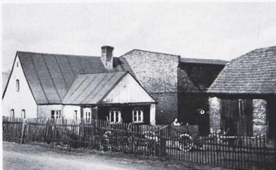
Abb. 183. Verputzter Holzbau und Ziegelrohbau.
