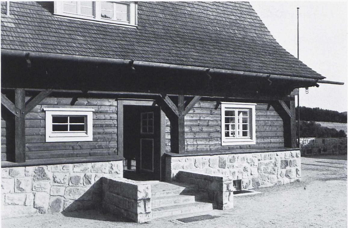
*Abb. 189 b. Längsseite desselben Hauses mit Umgebinde und Verbretterung.*
