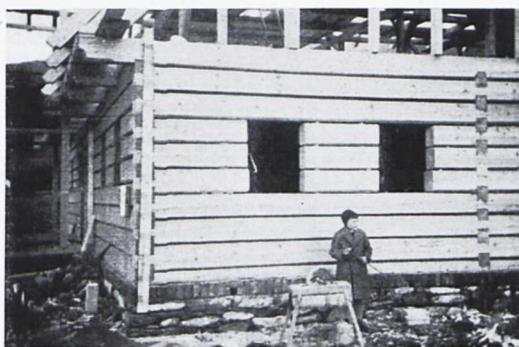
Abb. 21 und 22. Aufbau einer Blockwand im Riesengebirge.
